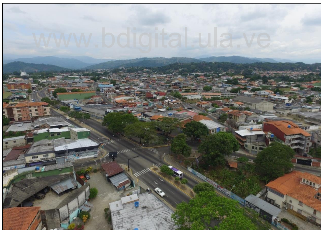
Figura 37. Vista aérea de la Avenida Don Pepe Rojas, sobre la T-001. Fotografía tomada con un dron, cortesía de @dmentertainment1.
