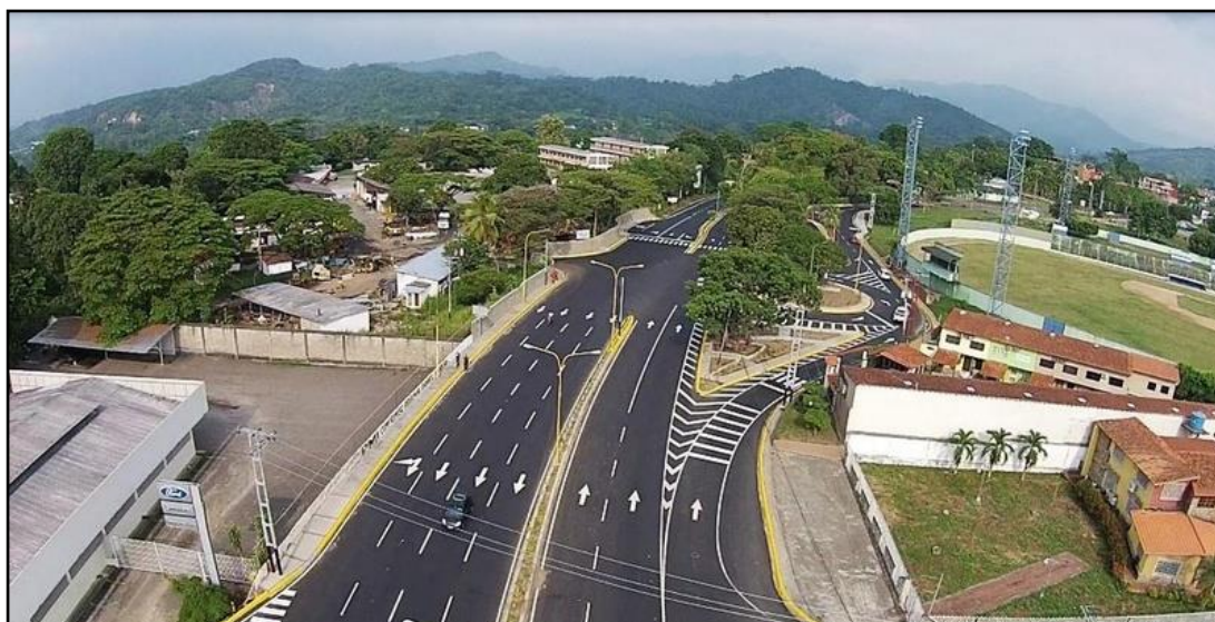
Figura 4. Vista aérea del Distribuidor Iberia, cerca del complejo deportivo Carlos Maya, en la ciudad de El Vigía. Fotografía extraída de la dirección web: www.skyscrapercity.com
