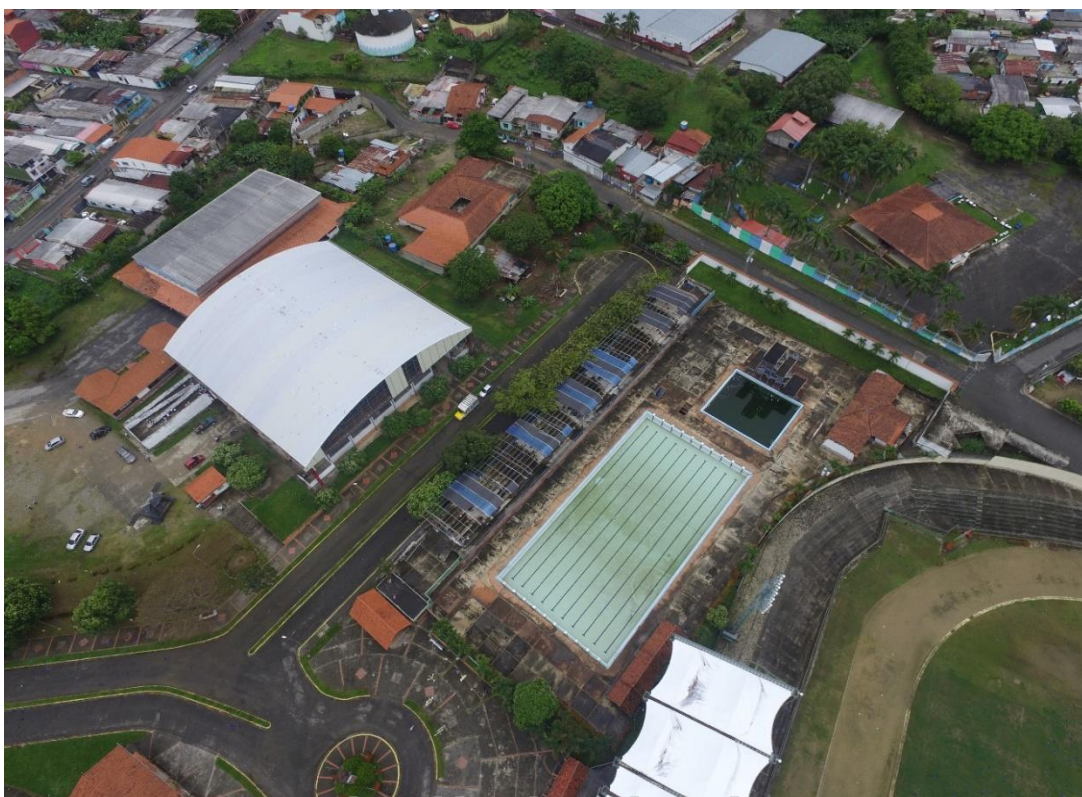
Figura 29. Vista aérea del complejo deportivo Carlos Maya. Fotografía tomada con un drone, cortesía de @dmentertainment1.
