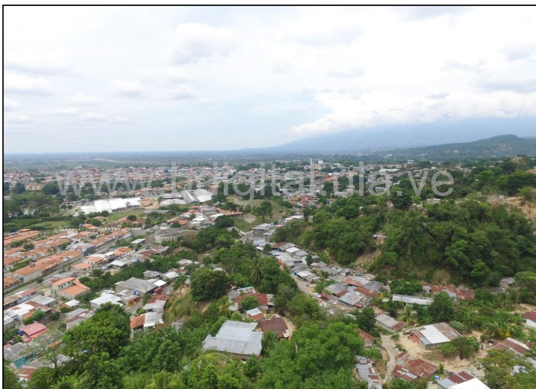
Figura 41. Vista aérea de viviendas consolidadas en la Urbanización Lago Sur (izquierda) y barrios 23 de Enero, 5 de Julio y San José (derecha). Fotografía tomada con un dron, cortesía de @dmentertainment1.
