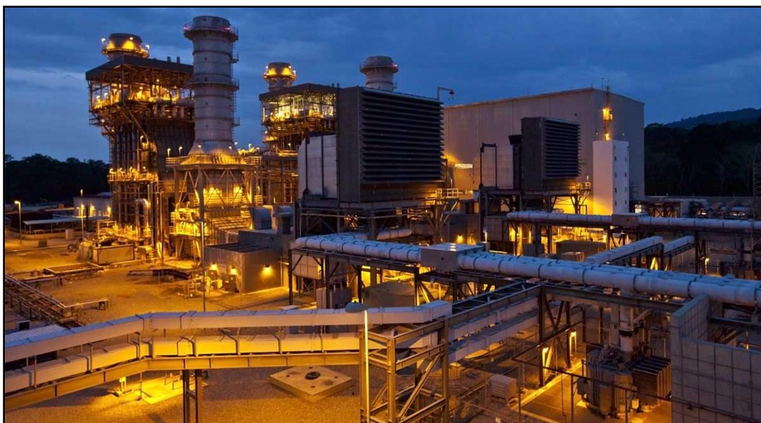
Figura 19. Planta termoelectrica Don Luis Zambrano de El Vigía. Fotografía extraída del sitio web: http://pasteninternational.com/portfolio-posts/232/
