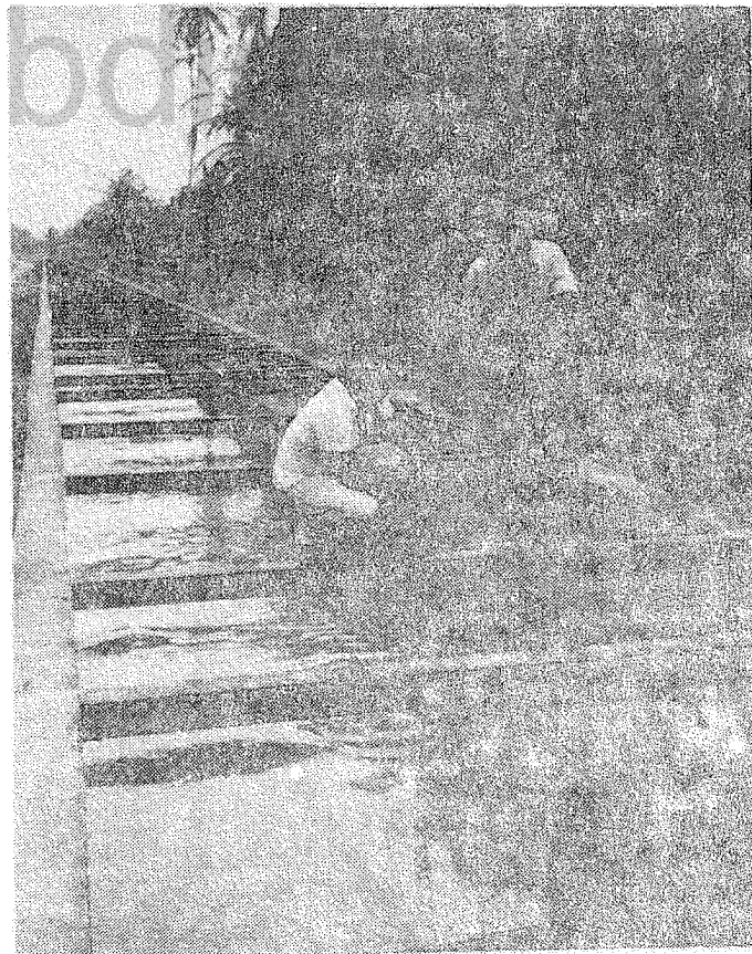
Figura 8. Aforo en el canal rectangular de concreto.
