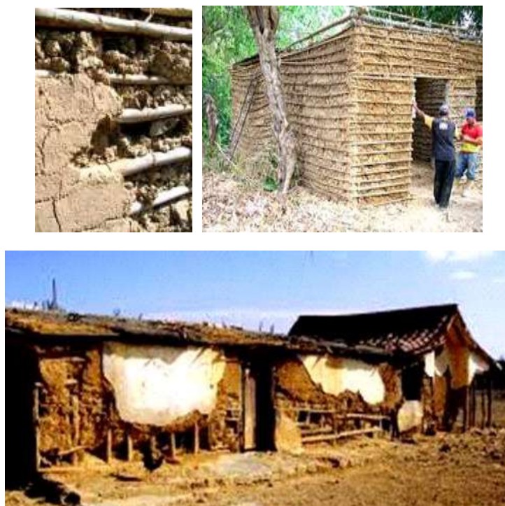
FIGURA 24. Detalle constructivo del bahareque exponiendo las cañas bravas y la tierra de relleno y posterior friso de una churuata maquiritare; una vivienda campesina y vista de una vivienda falconiana manufacturada con esta técnica ancestral. Fuente: Contreras et al. (2015).
