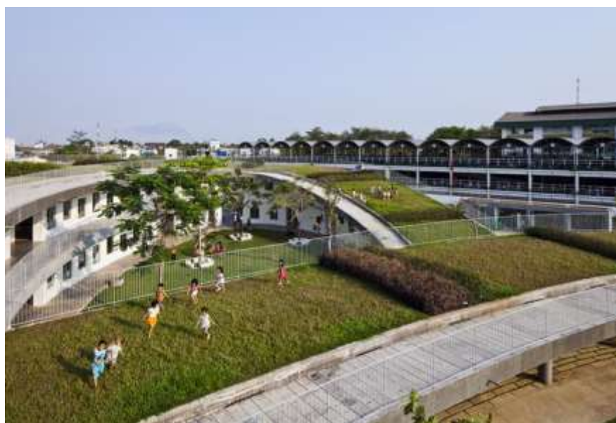
FIGURA 16. Vistas de todos los componentes construidos estructurales, cerramientos y techos verdes en rampa de la Escuela Baan Nong Bua, la cual está sobre pilotes. Fuente: Fotografías de Hiroyuki Oki Gremsy.
