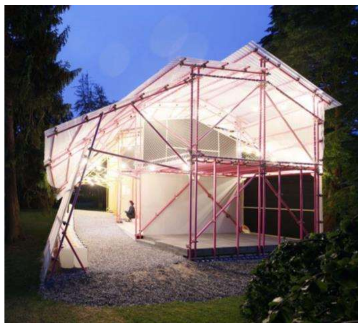
FIGURA 20. Vista externa del pabellón Louisiana Hamlet Pavilion del Museo Louisiana en Dinamarca y futura Escuela Kibera Hamlets, en Kenia, realizada con sistema de andamios metálicos, materiales de reciclaje y cobertura de láminas plásticas translúcidas. Fuente: Cano Helloeverything (2017).
