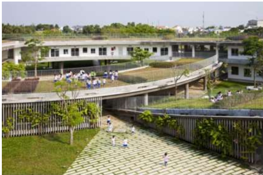
FIGURA 17. Vistas del entrecruzamiento de las rampas visitables y educativas en actividad de siembra de verduras de la Escuela Baan Nong Bua, la cual está sobre pilotes. Fuente: Fotografías de Hiroyuki Oki Gremsy.
