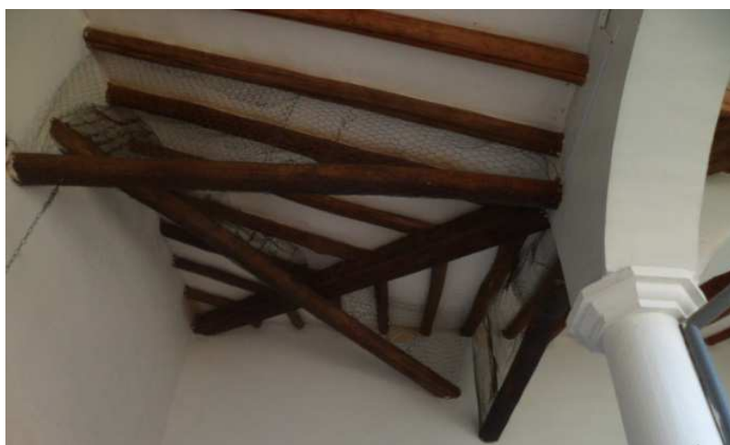
FIGURA 8. Sistema de enlace columnas esquineras (en concreto armado) con estructura de techos y tapias: limatón (madera estructural aserrada), continuación de la solera del patio (rolas de madera estructural) hacia las tapias y pieza en escuadría entre tapias (rola de madera estructural). Fuente: Elaboración propia.
