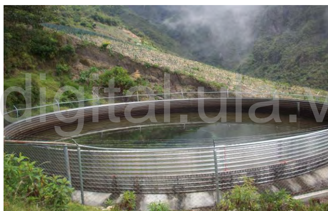
Fig. 9. Tanque Australiano Fuente: Propia
