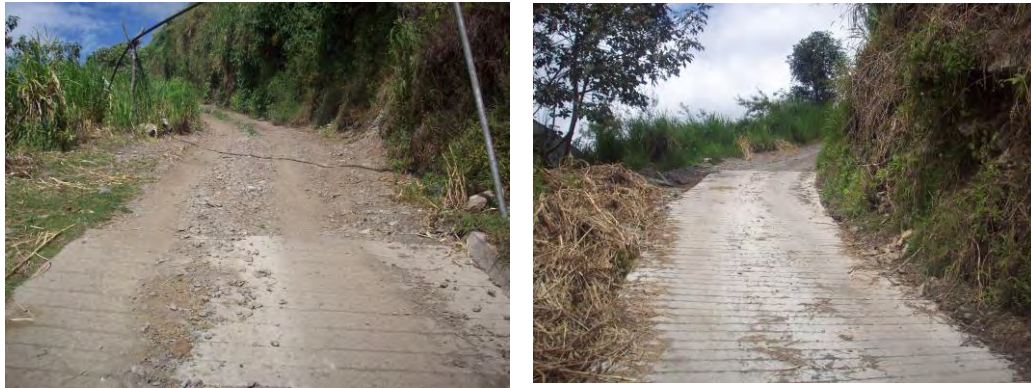
Antes y Después de la Pavimentación
