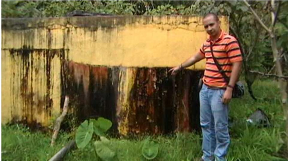
*Figura 5.11.* Condiciones externas de la obra de almacenamiento
