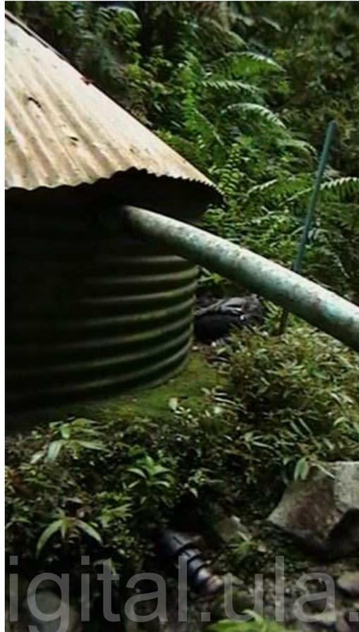
*Figura 5.6.* Tubería aliviadero (superior) y de limpieza (inferior)
