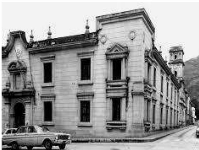
Edificio donde funciona el Vicerrectorado Académico (13)
