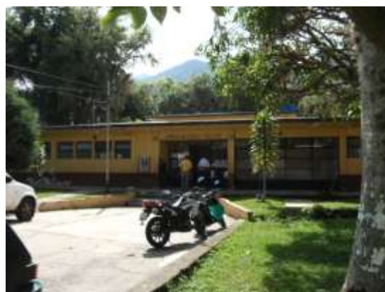
Remodelación del antiguo Hospitalito, 1955. Fotografía tomada por el autor.
