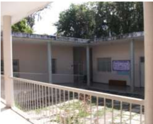
Remodelación del antiguo Hospitalito, 1955. Fotografía tomada por el autor.
