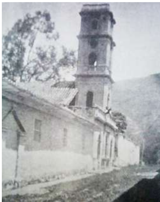
Fachada a la Calle Vargas (26)
