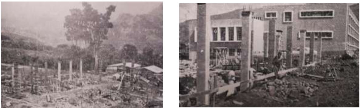
Primeras etapas en la construcción del nuevo edificio (agosto 1955) (8)
