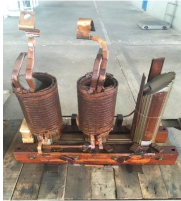
Figura 4.10 Desarme de parte activa.
