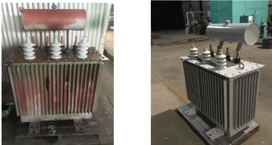
Figura 4.7 Antes y después de la aplicación de pintura al transformador "LUISCERRANO1/19".
