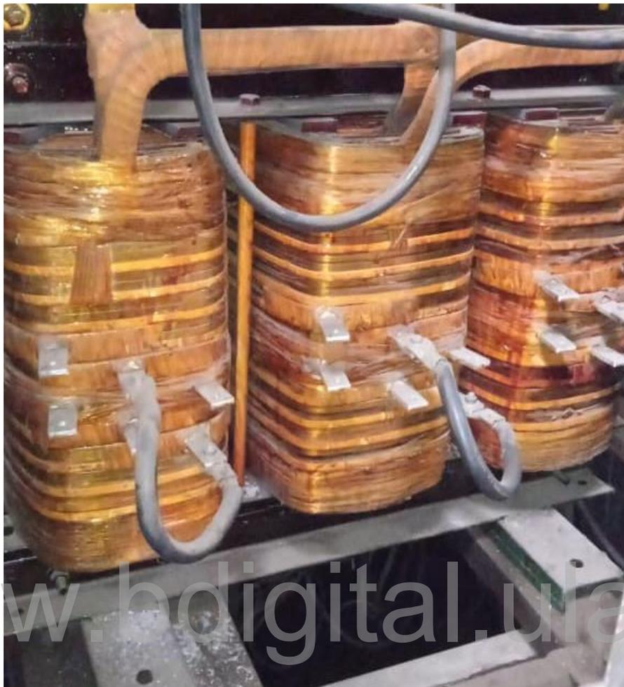
**Figura 3.8 Transformador de alumbrado**
