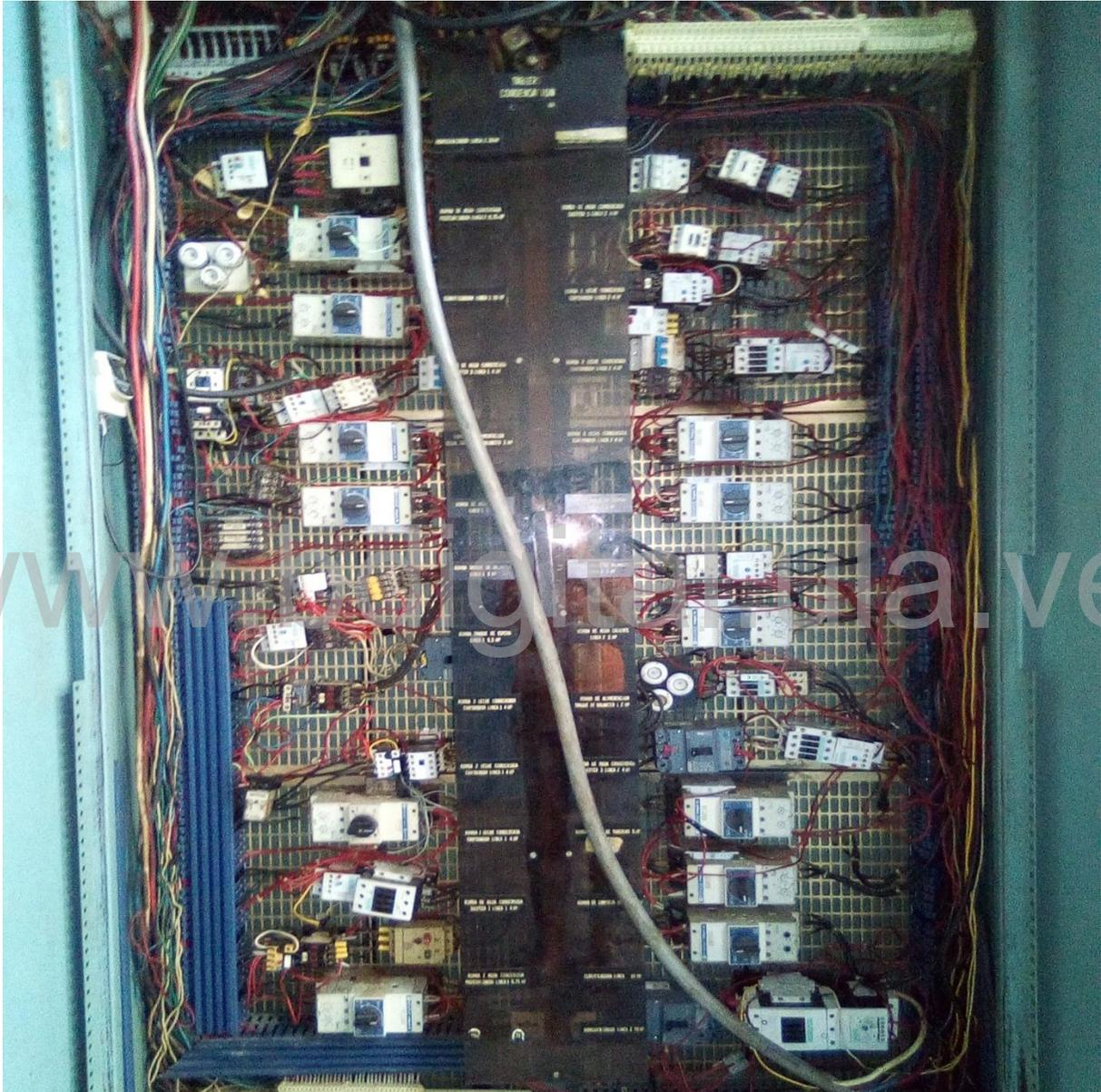
**Figura 3.5. Tablero de condensación**
