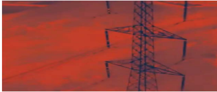
Fig. 5.23 Imagen aérea termografía tomada por un dron matrice 300 rtk [20].
