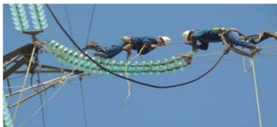
Fig. 5.26 Maniobra de cambio de aislamiento en estructura de tipo tensión [12].
