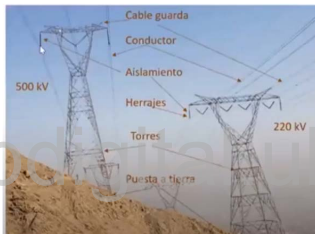
Fig. 4.2 Componentes de las líneas de transmisión [10].
