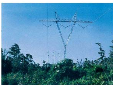
Fig. 4.11 Torres retenidas en Y [16].
