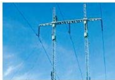
Fig. 4.10 Torre retenida tipo portal [16].
