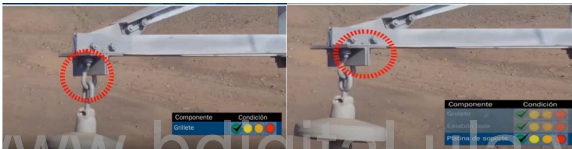
Fig. 5.10 (a) Parte de una inspección visual con Drone de estructura y herrajes [20].
