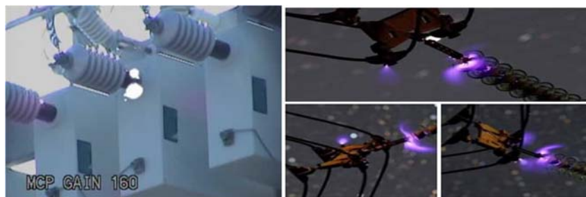
Fig. 3.11 Imagen que visualiza las descargas por efecto corona [12].
