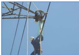
Fig. 5.25 Maniobra cambio de aislamiento en estructura de suspensión.
