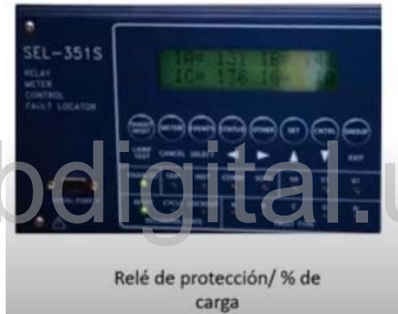
Fig. 5.20 Relé de protección, indicando los valores de las corrientes en las líneas [20]
