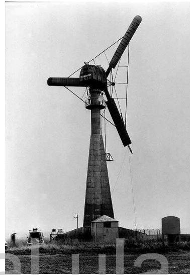
Figura 2.4. Turbina eólica Gedser [4].
