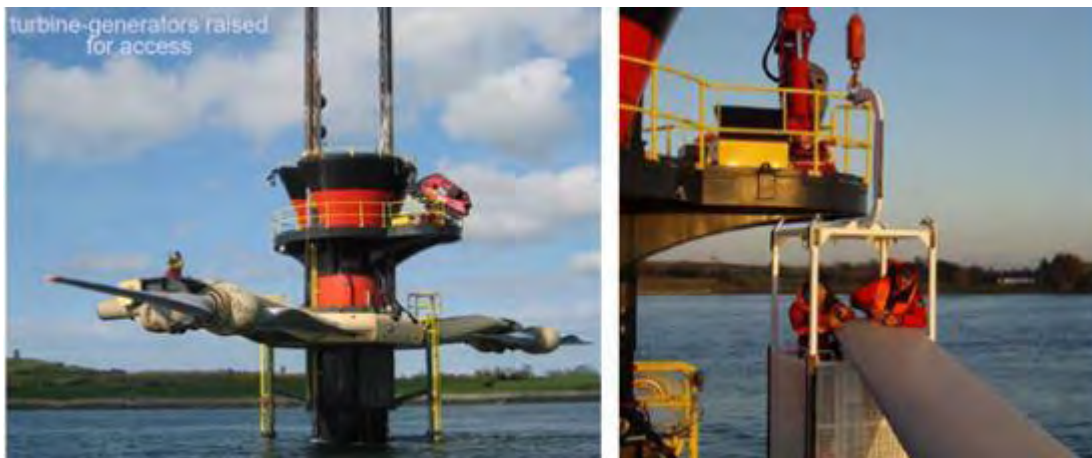
Figura 2.8: Elevación de los rotores del SEAGEN para mantenimiento. Fuente: google imágenes.
