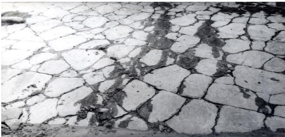
44.-Detalle de la estructura El Porvenir. Uribante
