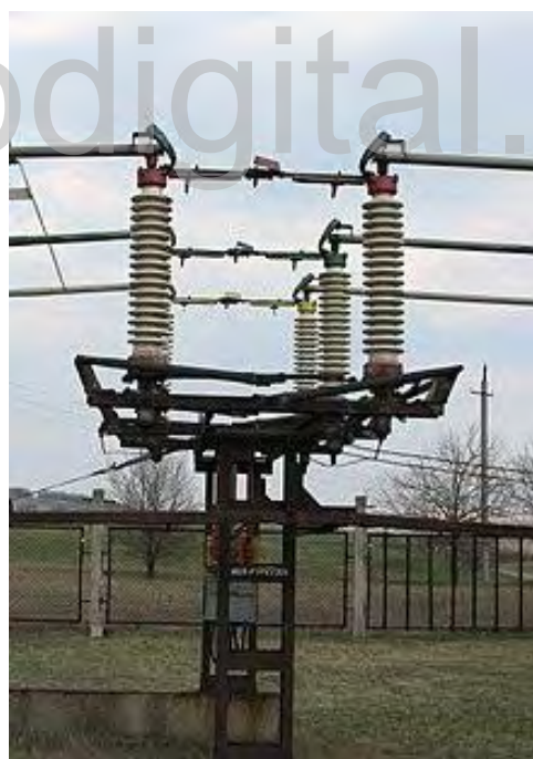
Figura 2. Vista de perfil de un seccionador trifásico. [6].
