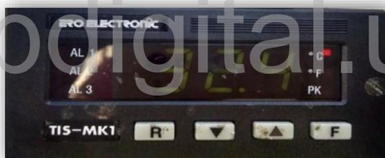
**Fig. 3.19. Indicador de temperatura del bobinado.**
