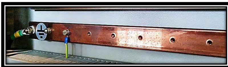
**Fig. 3.67. Vista de la barra colectora de tierra de las celdas de MT en la SEAT.**
