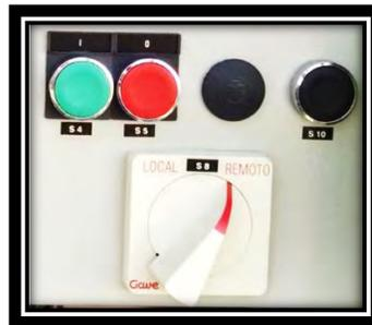
Fig. 5.26. Posición remoto del seccionador H-103.
