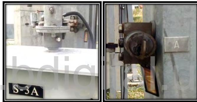
**Fig. 5.10. Seccionador H-114 con llave de enclavamiento ubicada en la cerradura de bloqueo.**
