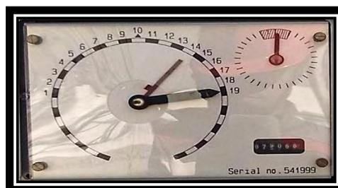
**Fig. 3.13. Indicador de toma conectada y contador de operaciones de cambio de toma.**
