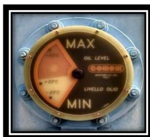
**Fig. 3.26. Indicador del nivel de aceite del tanque de expansión del trafo.**
