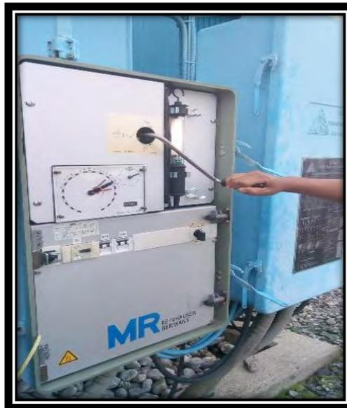
**Fig. 5.9. Giro de la manivela para cambiar los taps del trafo.**
