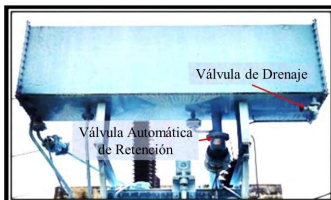
**Fig. 3.9. Vista frontal del tanque conservador del trafo de potencia.**
