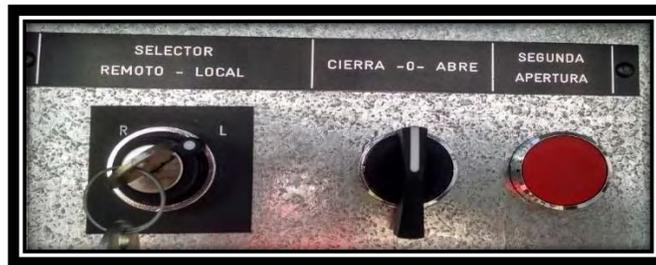
**Fig. 5.25. Selector en posición local del disyuntor H-105.**
