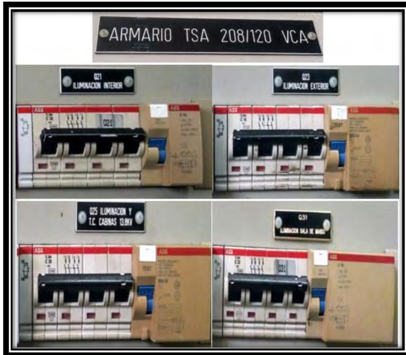
**Fig. 4.7. Protecciones de circuitos de iluminación.**
