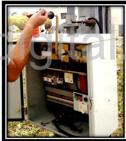
**Fig. 5.32. Giro de la manivela para apertura o cierre del seccionador H-103.**
