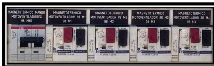
**Fig. 3.20. Protecciones del sistema de refrigeración motoventiladores.**
