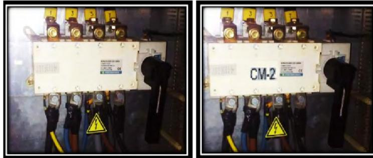
**Figura 5.39. Conmutadores CM1 y CM2 Ubicados en la Posición Dos.**
