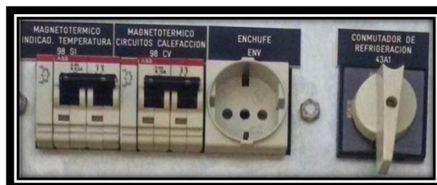
**Fig. 3.18. Protecciones del indicador de temperatura, del circuito de calefacción, un conector especial, y un conmutador del sistema de refrigeración.**
