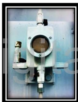
**Fig. 3.25. Dispositivo de purga del relé buchholz del trafo.**
