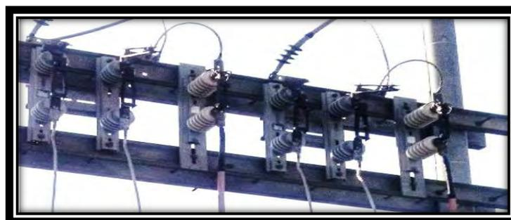
**Fig. 3.49. Seccionador tipo bypass circuitos de salida.**
