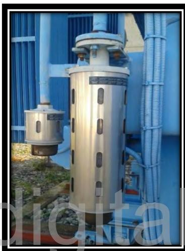
**Fig. 3.16. Deshidratador de aire del cambiador de taps (envase pequeño) y deshidratado del tanque de expansión (envase grande).**
