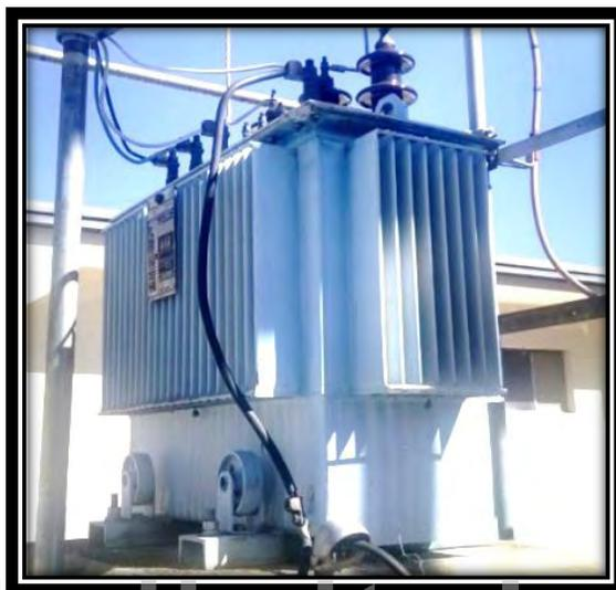
Fig. 3.76. Trafo trifásico OASA 13,8 kV / 225–215 V, de potencia nominal de 160 kVA, alimenta el armario del TSA 220/127 VCA.
