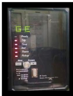
**Fig. 3.60. Equipo de protección MIF instalado en la SEAT.**
