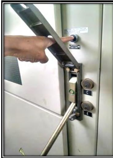
**Fig. 5.15. Enclavamiento de puesta a tierra de la cabina A1.1.**
