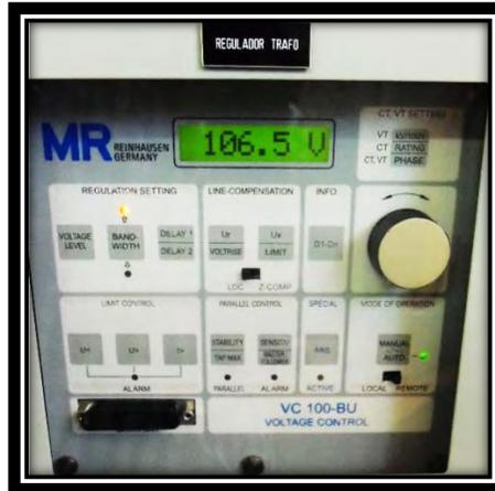
**Fig. 5.5. Observación del diodo led para el modo manual-auto del regulador trafo.**
