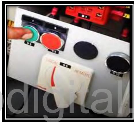
**Fig. 5.30. pulsador verde para cerrar el seccionador H-103.**
