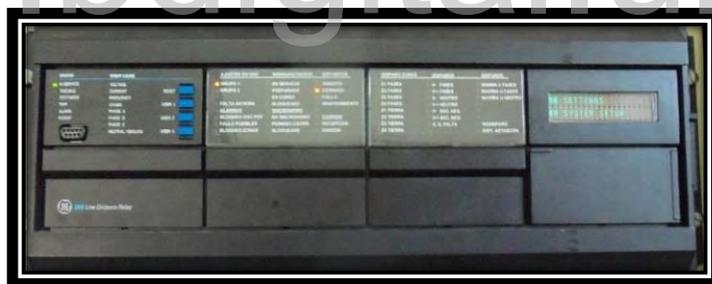
**Fig. 3.59. Equipo de protección d60 instalado en la SEAT.**
