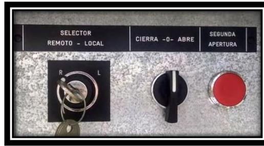
**Fig. 5.17. Selector en posición remoto del interruptor H-105.**
