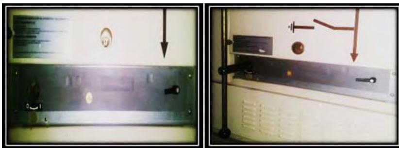
**Fig. 5.16. seccionador de puesta a tierra de la cabina a2.**
