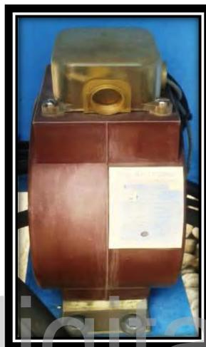
Fig. 3.73. Trafo de intensidad IFH-3, instalados en la SEAT.
