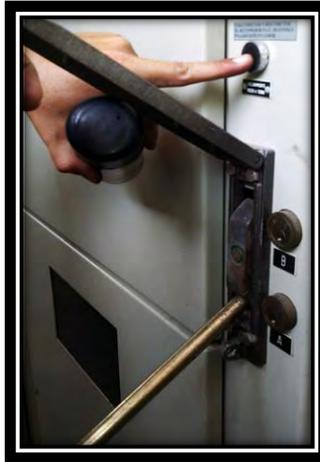
**Fig. 5.13. Enclavamiento de puesta a tierra de la cabina a0.**
