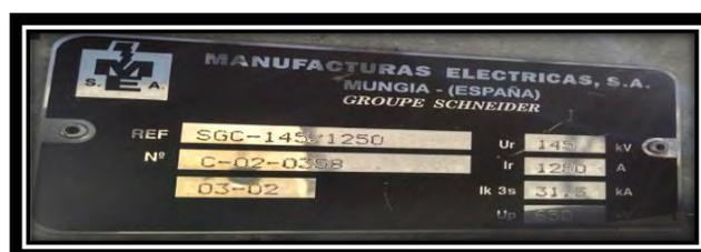
**Fig. 3.46. Placa de datos del seccionador.**
