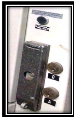
**Fig. 5.11. Cerraduras para el enclavamiento de puesta a tierra de la cabina A0.**
