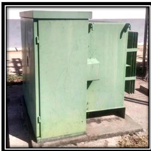
Fig. 3.77. Trafo trifásico CAIVET 13,8 kV / 208Y–120 V, con potencia nominal de 150 kVA. Alimenta el armario del TSA 208/120 VCA.
