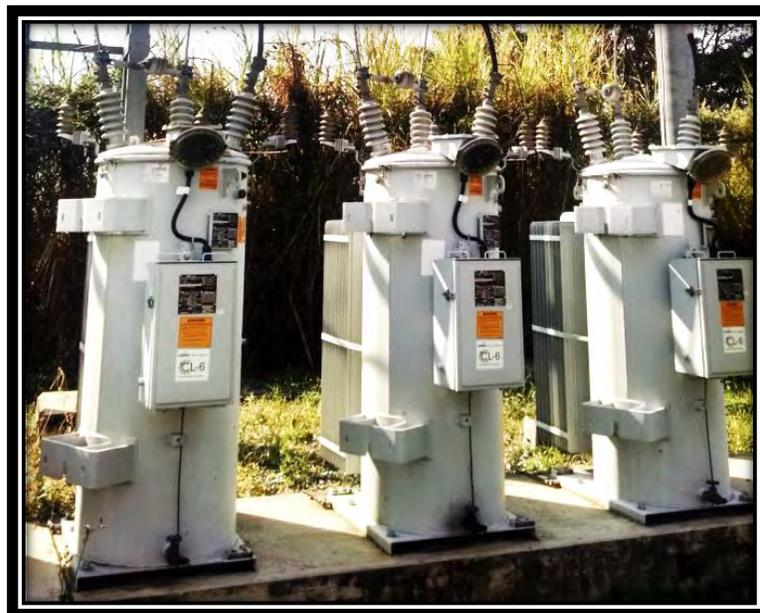
**Fig. 3.75. Reguladores de tensión dispuestos en la SEAT.**
