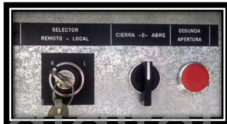
**Fig. 5.21. Selector en posición remoto del interruptor H-105.**
