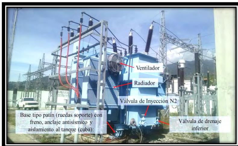
**Fig. 3.7. Vista posterior del trafa de potencia.**
