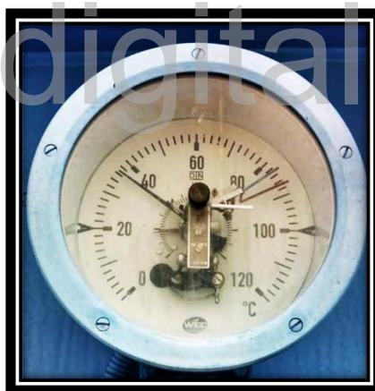
**Fig. 3.27. Indicador de la temperatura del aceite del trafo.**
