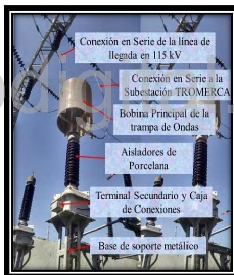
**Fig. 3.41. Tampa de onda instalada en la SEAT.**
