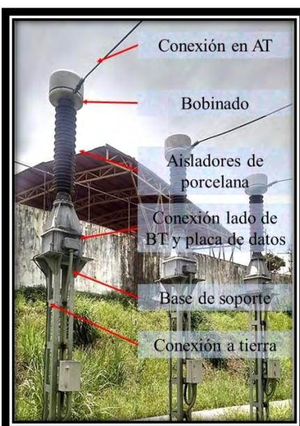
Fig. 3.56. Trafo de potencial inductivo (TP) instalado en la SEAT lado trafo de potencia.
