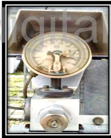
**Fig. 4.1 indicadores de sf6 del interruptor de potencia de AT.**
