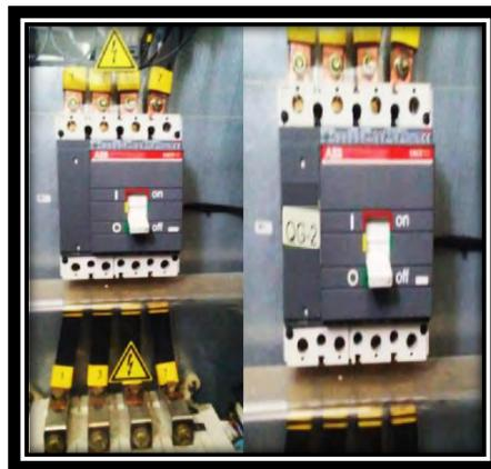
Figura 5.38. Termomagnéticos QG1 y QG2 Ubicados en Posición OFF.
