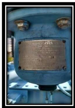
**Fig. 3.24. Válvula automática de retención del trafo.**
