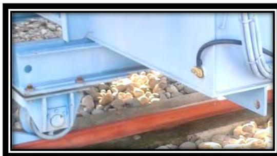
**Fig. 3.17. Conector de puesta a tierra del trafa de potencia.**
