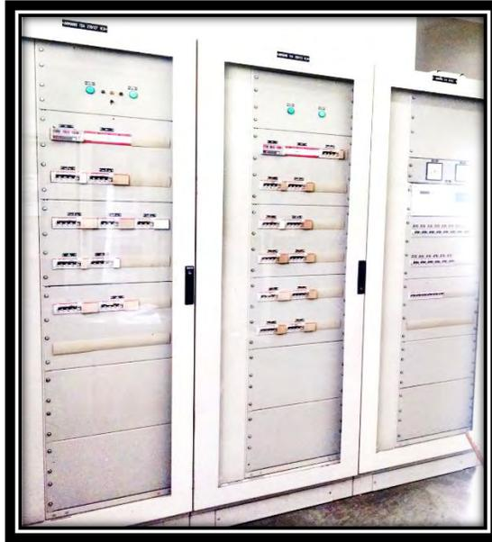
**Fig. 4.6. Armarios de servicios auxiliares de CA y CC.**
