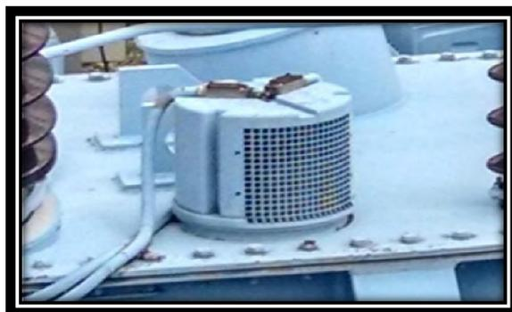
**Fig. 3.28. Válvula de sobrepresión del trafo.**
