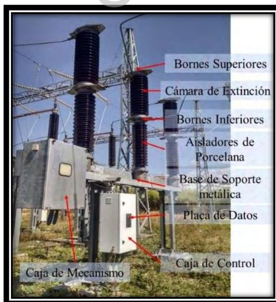
Fig. 3.38. Interruptor de potencia (disyuntor) instalado en la SEAT.
