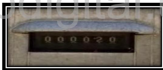
**Fig. 3.34. Contador de descarga del descargador.**
