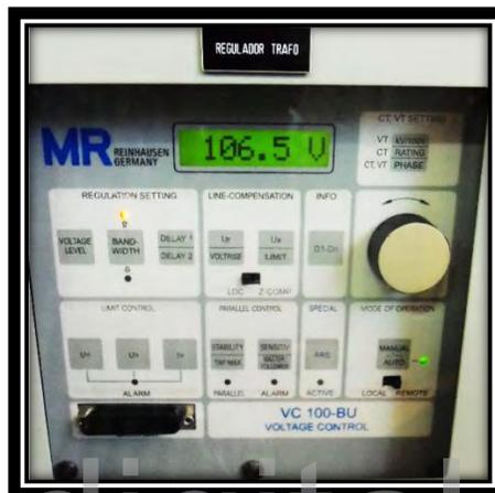
Fig. 5.3. Observación del diodo led para el modo manual-auto del regulador trafo.
