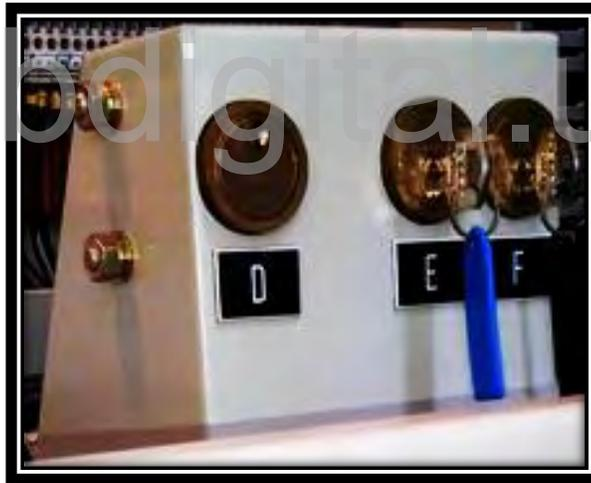
**Fig. 5.14. Llaves para el cierre del seccionador de puesta a tierra de la cabina A1.1.**
