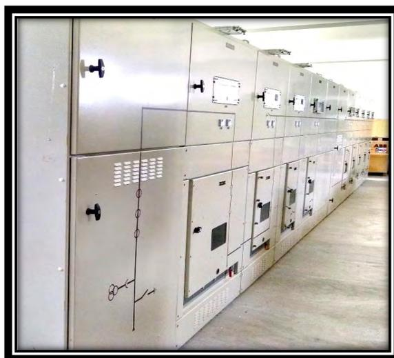
**Fig. 3.64. Vista frontal de las celdas de 13,8 kV en la SEAT.**
