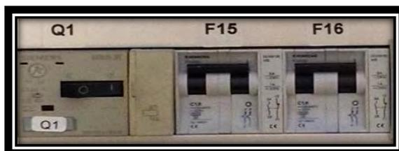
Fig. 3.11. Q1 protector de motor, F15-F16 cortacircuitos automáticos de 1.6 A.
