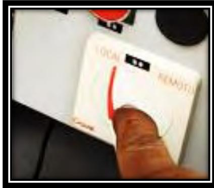
**Fig. 5.29. posición local del seccionador h-103.**
