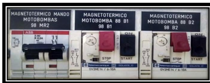
**Fig. 3.21. Protecciones del sistema de refrigeración motobomba.**
