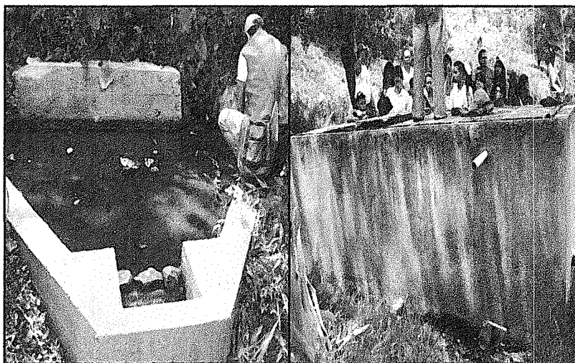
Figura 59. Práctica de campo, segunda estación (Dique de captación del recurso agua y desarenador donde llegan las 5 mangueras.
