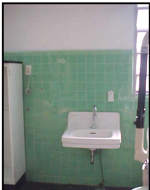
Foto. N° 1: Sala Clínica de Cirugía. Baldosas no acorde con las normas actuales de bioseguridad. No hay secador de manos
