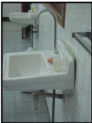
Foto. N° 1: Sala Clínica de Cirugía. Baldosas no acorde con las normas actuales de bioseguridad. No hay secador de manos
