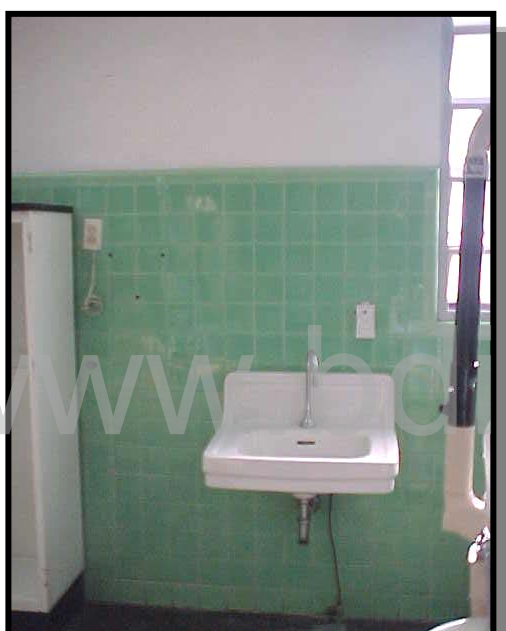
Foto. N° 1: Sala Clínica de Cirugía. Baldosas no acorde con las normas actuales de bioseguridad. No hay secador de manos
