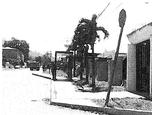
Figura 30: Señalización vertical en mal estado
