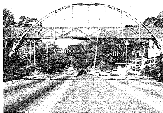
Figura 14: Distancia vertical o galibo en vías urbanas
