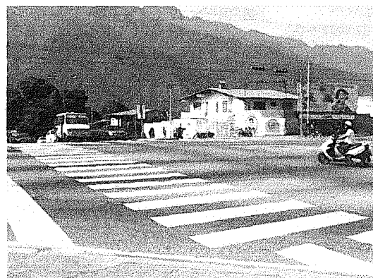
Figura 28: Pendiente longitudinal en un acceso de intersección
