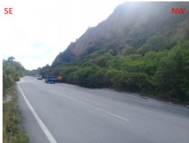
Figura 49. Vialidad de la Troncal 007, construida sobre la masa deslizada del deslizamiento Las González.
