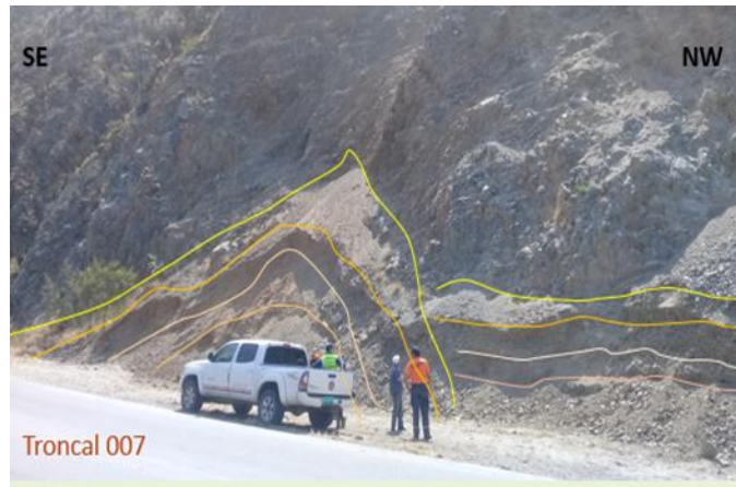
Figura 18. Cono de detritos (superpuestos), que generan problemas de transitabilidad vial. Afloramiento de la Asociación Tostós
