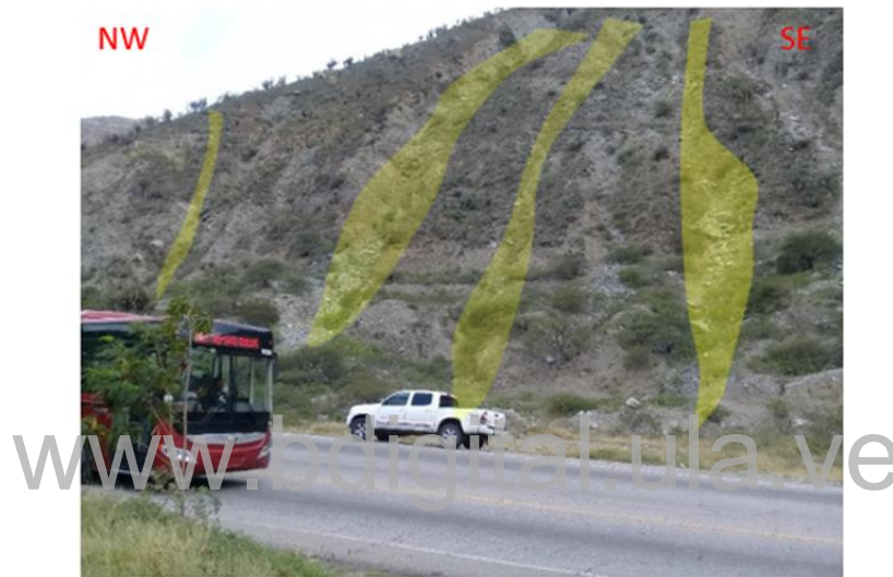
Figura 53 Asociación Tostós (esquistos), con evidencia de cárcavas y surcos que generan problemas de transitabilidad en la Troncal 007.
