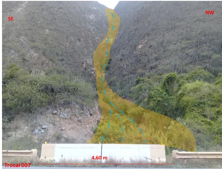
Figura 23. Cajón hidráulico, cubierto por vegetación, gravas y arenas.
