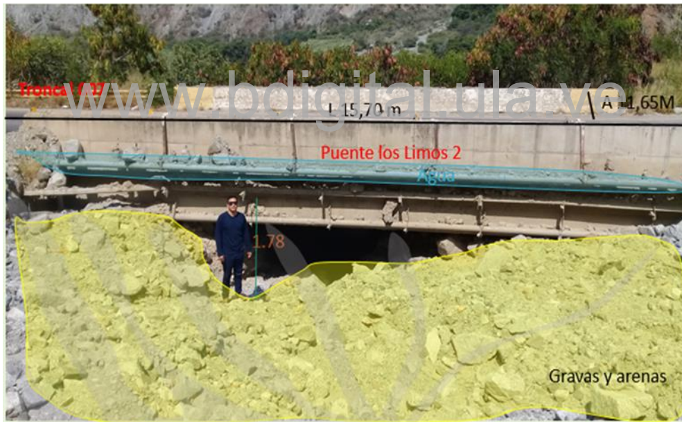
Figura 24. Material de grava y arena depositado por un flujo de detritos.
