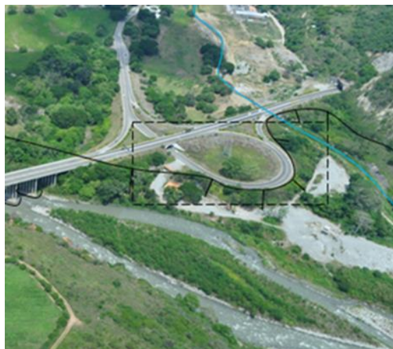
Figura 36. Pedraplén ubicado en el sector Los Estanques de la troncal 007.
