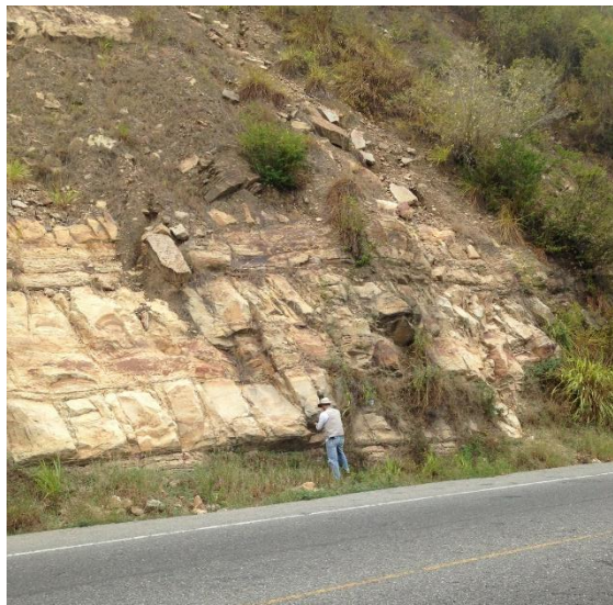
Figura 4. 5 Macizo rocoso presente en el talud 3
