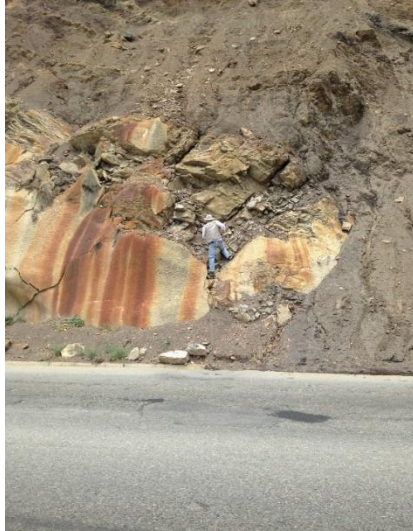
Figura 4. 3 Mediciones del macizo rocoso presente en el talud 1
