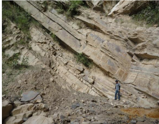
Figura 4. 4 Afloramiento rocoso presente en el talud 2
