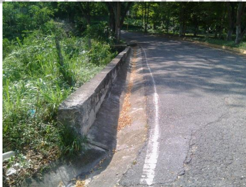
Figura 58. Progresiva 26+420. Obra de drenaje (cuneta) operativa.
