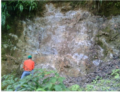
Figura 47 Progresiva 10+460. Medición de ángulos de Rumbo y buzamiento. R= S14^{\circ}E ; B=25^{\circ}
