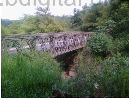
Figura 56 Progresiva 2++240. Puente tipo guerra, ancho 3.75 metros, largo 28.00 metros
