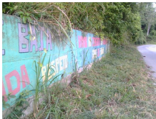
Figura 54. Progresiva 23+090. Muro armado para contención de detritos.
