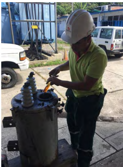
Figura 4.7 Toma de la muestra de aceite del transformador en estudio.
