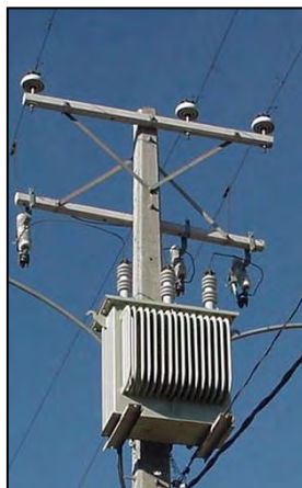
Figura 2.5 Transformador trifásico tipo poste/estación.
