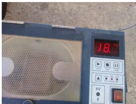
Figura 4.9 Elaboración de la prueba de rigidez dieléctrica al aceite del transformador en estudio.
