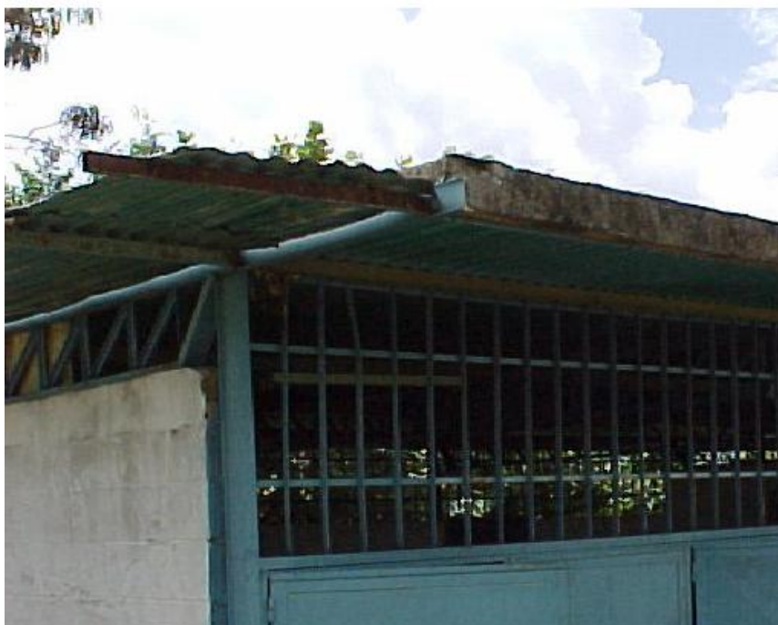
Imagen 4.7: Fotografía de platabanda de cemento vaciada en techo de escuela modelo R1. (Fuente FEDE 2001).
