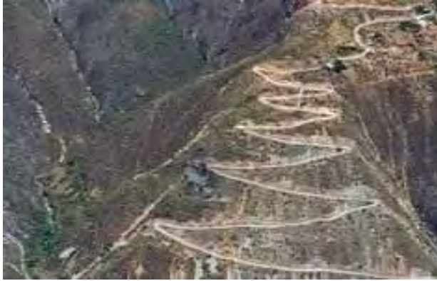
Figura 2. Vista aérea del camino hacia los Pueblos del Sur, estado Mérida, Venezuela. Tomado de: http://www.pinterest.com/pin/4742855404490440311
