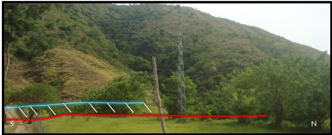
Figura 6.5 Entrada hacia una pequeña hacienda ubicada en el Portachuelo, donde se logró evidenciar el escarpe de falla sobre el terreno y su desnivel.
