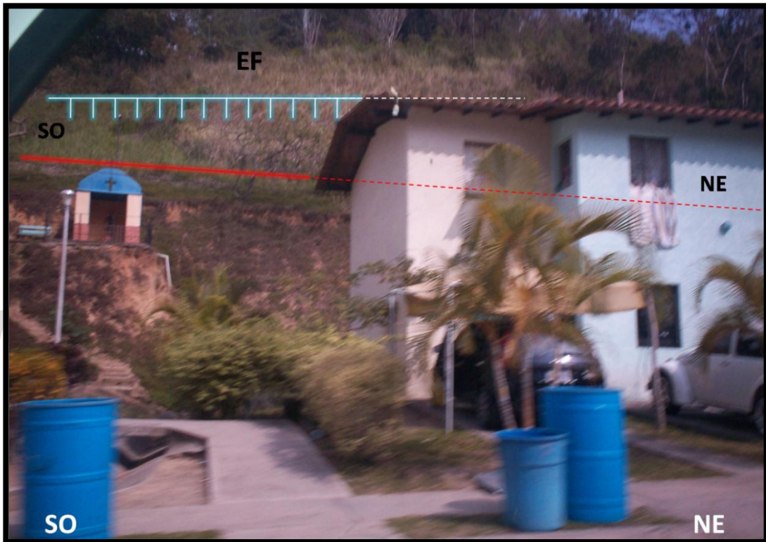
Figura 6.28 En esta fotografía se puede observar la zona donde antiguamente se encontraba una berma de falla la cual fue removida para realizar la construcción que observamos en la misma. Al fondo se puede observar un escarpe de falla que denota el paso de la misma. EF: Escarpe de falla.
