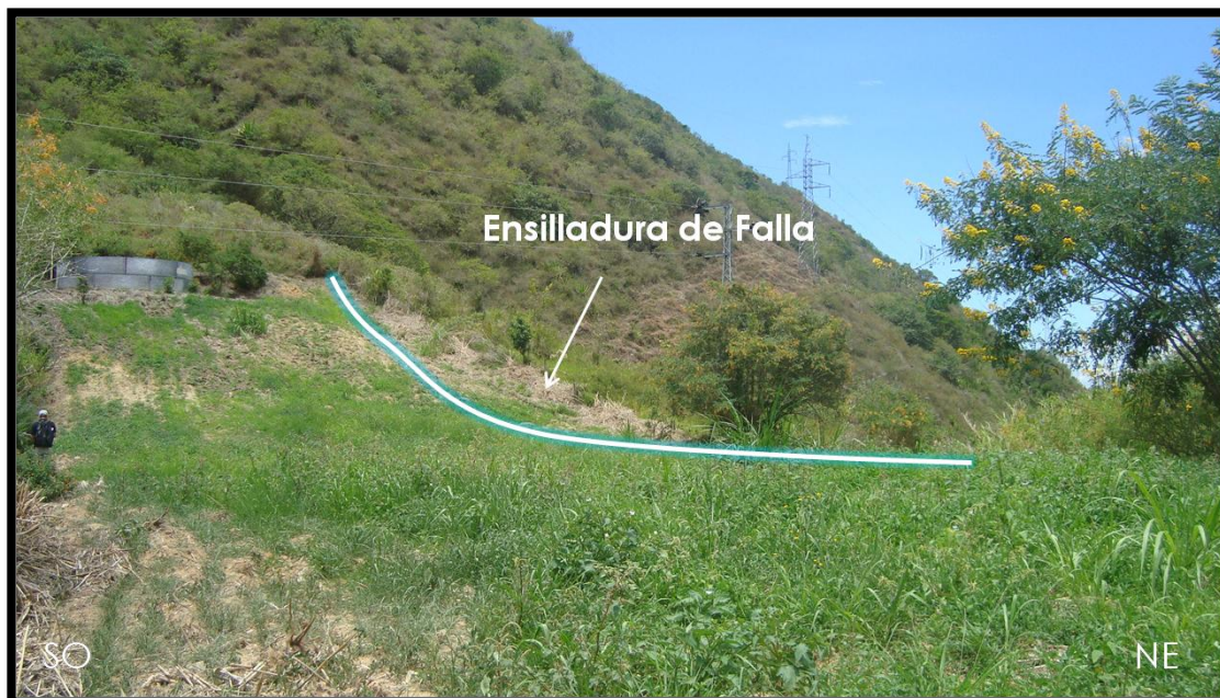
Figura 6.41. Ensilladura de falla situada justo al lado del tanque de INOS. Sector: La Playa. Coordenadas: N919189, E 192827.
