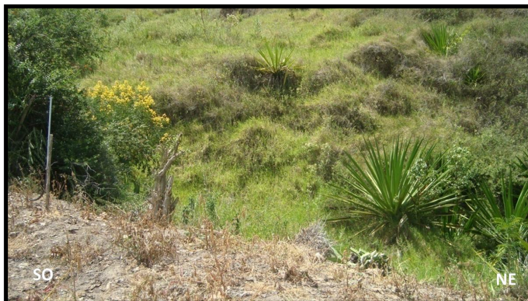
Figura 6.40. Trinchera de falla. Coordenadas: N919250, E192988.
