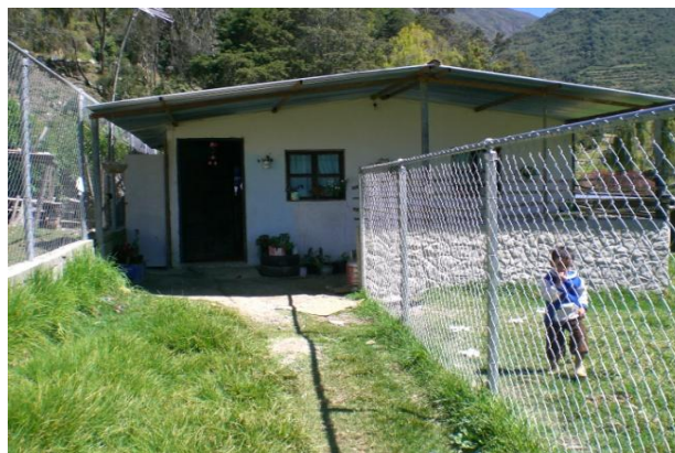
Imagen N° 42: Mantenimiento adecuado de las viviendas y utilización de materiales de fácil transporte y colocación. Fuente: La autora/2011.
