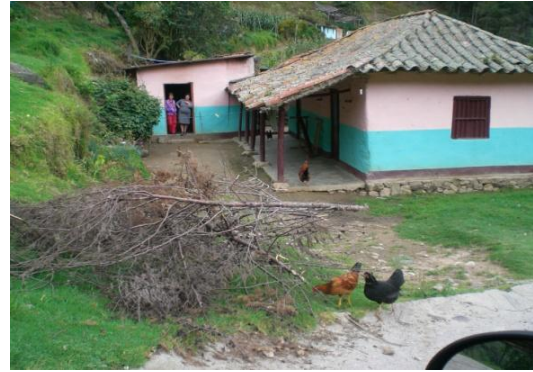
Imagen N° 10: Construcción de ampliaciones que afectan la tipología original del inmueble/2009. Fuente: La autora.
