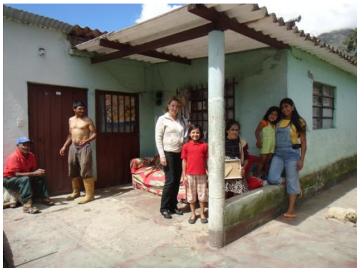
Imagen N° 43: Materiales inadecuados en la cubierta/2010.
