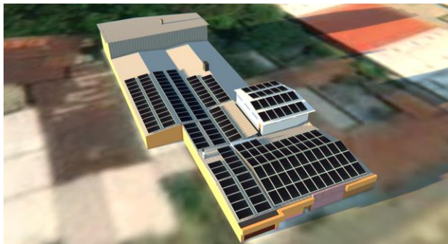
Fig. 5. Vista aérea de la instalación de paneles SFV, caso 1.
