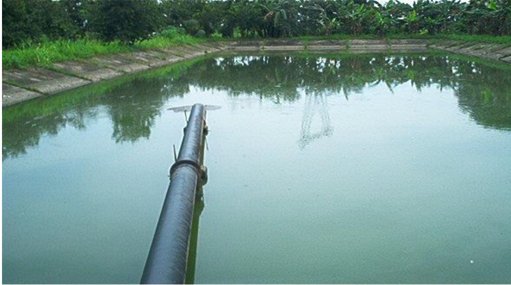
Figura 1.6 Laguna facultativa (única), vista aguas abajo. Sistema de lagunas de Caño Amarillo, municipio Alberto Adriani, Zona Panamericana, estado Mérida.
