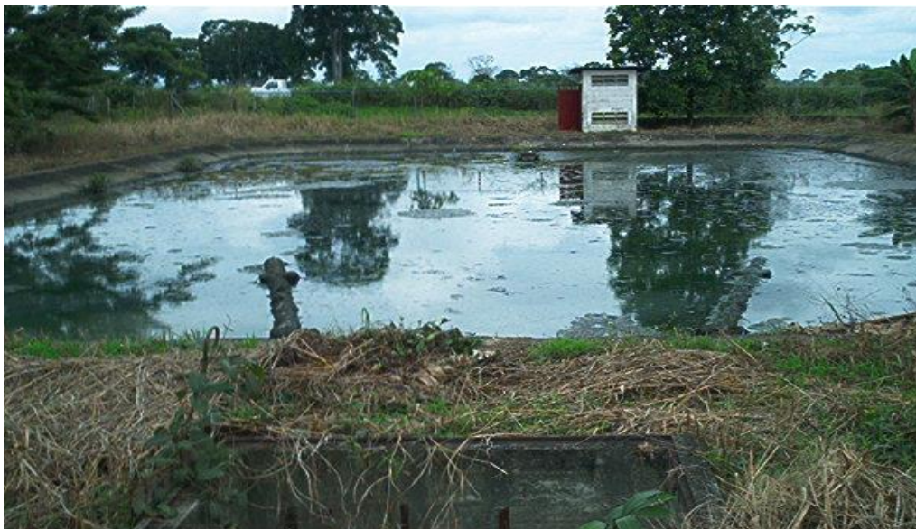
Figura 1.10 Laguna facultativa secundaria, vista aguas abajo. Sistema de lagunas de Guayabones, municipio Obispo Ramos de Lora, Zona Panamericana, estado Mérida. Se observa la caseta de cloración para desinfección del efluente.
