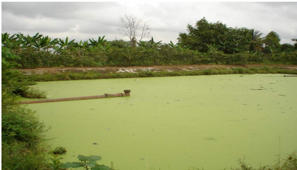
Figura 1.12 Laguna secundaria de la población de El Pinar, municipio Caracciolo Parra, Zona Panamericana, estado Mérida.
