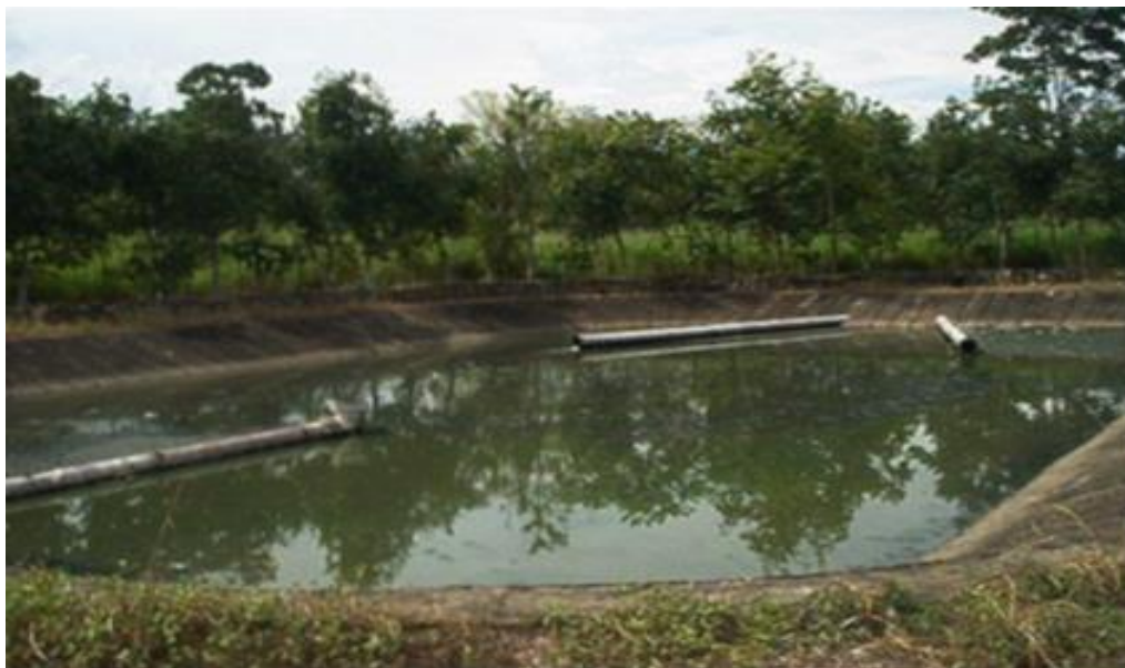
Figura 3.2 Laguna facultativa de 20m X 30 m y profundidad 1,50m, vista aguas arriba, implementada en Caño Seco, municipio Alberto Adriani, Zona Panamericana del estado Mérida.
