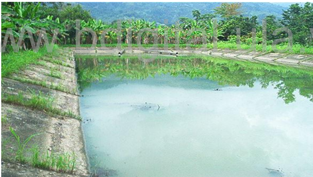
Figura 1.7 Laguna facultativa (única), vista aguas arriba. Sistema de lagunas de Caño Amarillo, municipio Alberto Adriani, Zona Panamericana, estado Mérida.
