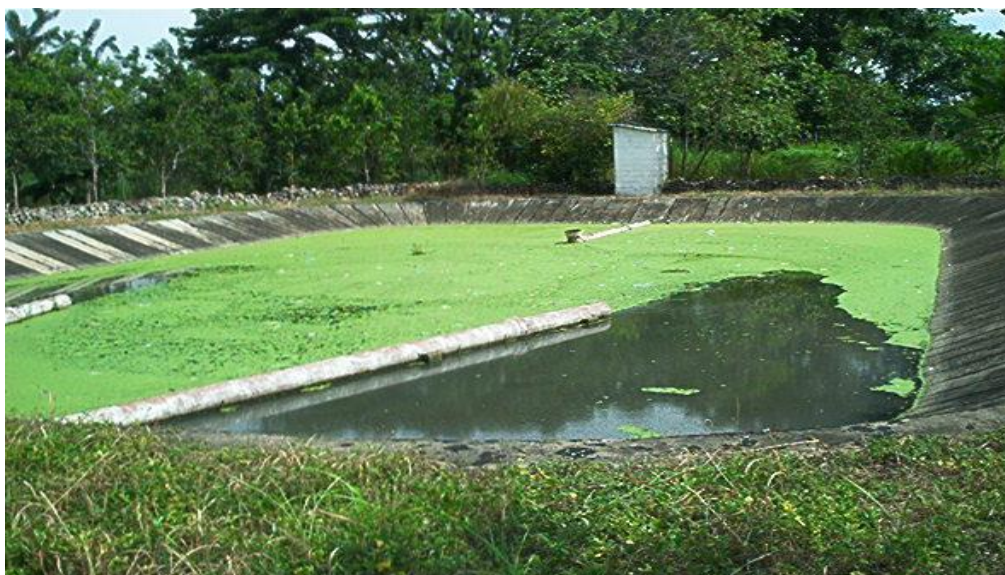
Figura 1.4 Segunda laguna facultativa, vista aguas abajo. Se observa la caseta de cloración para desinfección. Sistema de lagunas de Caño Seco, municipio Alberto Adriani, Zona Panamericana del estado Mérida.
