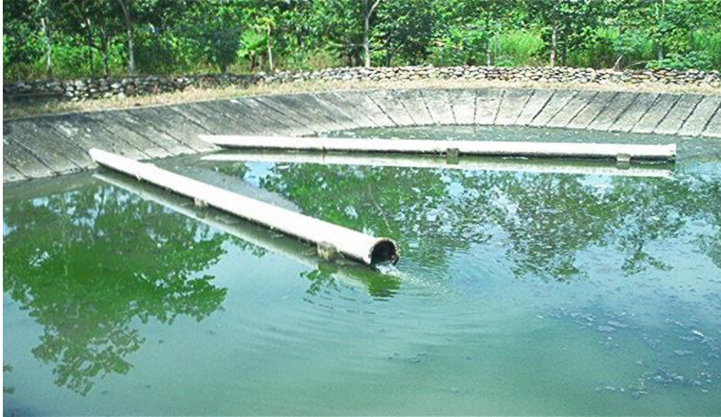
Figura 1.13 Tuberías de entrada a las lagunas. Sistema de lagunas de estabilización de Caño Seco, municipio Alberto Adriani, Zona Panamericana, estado Mérida.
