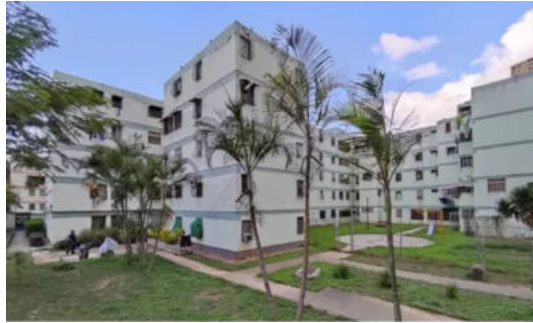
Imagen 18. Vista de conjunto del edificio tipo IM5
