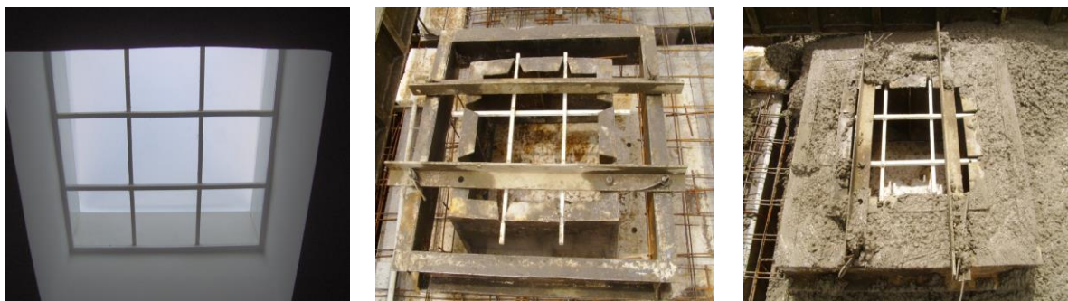
Figura 3. Innovación aplicada: Inclusión del protector de cúpula en el vaciado. Fuente: los autores
