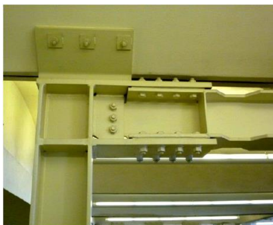
Figura 4. Detalle de una conexión viga-columna. Fuente: [7]
