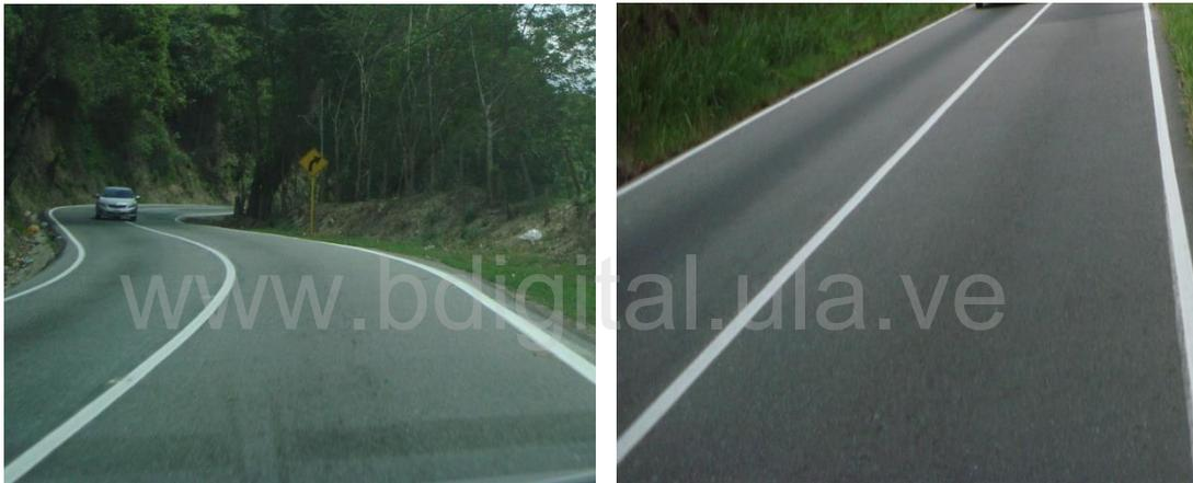
**Figuras 47 y 48. Demarcación de canales de circulación. Líneas longitudinales**
