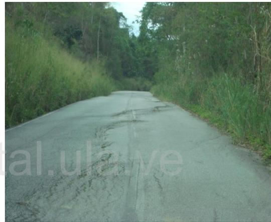
**Figura 26. Fallas estructurales en el pavimento (Ondulaciones y protuberancias)**
