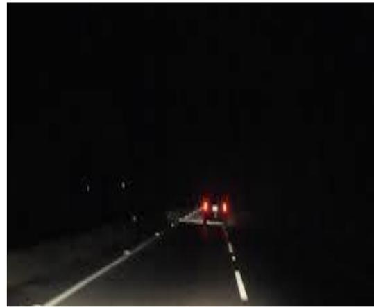
Figura 55. Demarcación elevada. Ojos de gato. Efecto de retroreflectividad. Visión nocturna.
