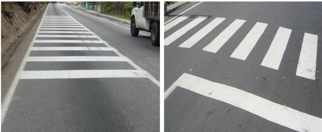
**Figuras 49 y 50. Demarcación. Líneas transversales en la carretera (reductor de velocidad, paso peatonal).**
