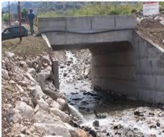
Figura 33. Vista lateral de un cajón de paso.
