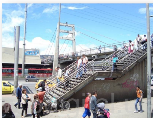
Figura 5.7. Acceso al Portal del Norte troncal Autonorte.
