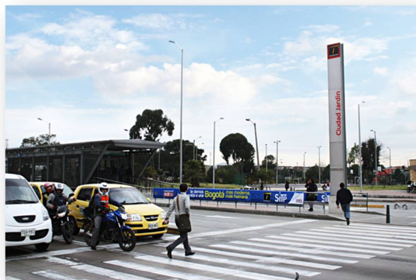
Figura 2.4. Cruces peatonales y semaforizados en el sistema de transporte público Transmilenio.
