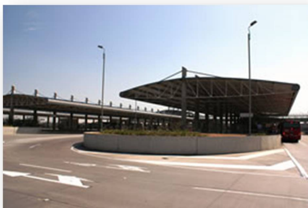
Figura 2.2. Estación de cabecera o portal de línea en el sistema de transporte público Transmilenio.
