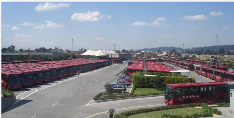
Figura 2.5. Patios de operación, mantenimiento y estacionamiento de autobuses en Transmilenio.
