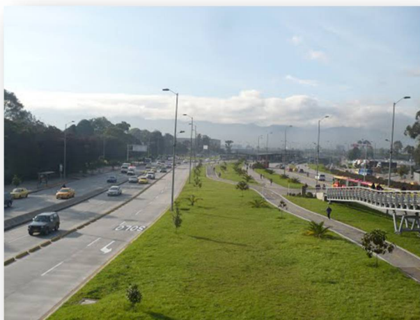
Figura 5.16. Imagen general tramo troncal El Dorado.
