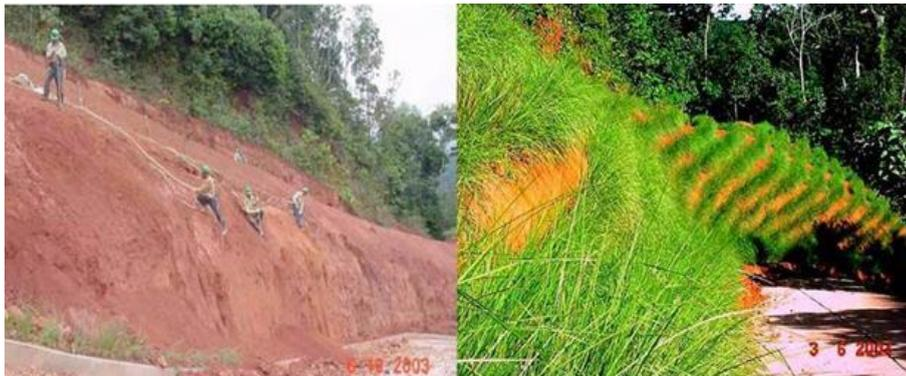
Figura 4. Usos del pasto vetiver<sup>6</sup> en la protección de taludes, como factor mitigante para los procesos erosivos, en vías de tránsito de fuerte pendiente y con problemas de caída de bloques de piedra, antes (izq.) y después (der.), en la mina de bauxita de Los Pijiguaos, estado Bolívar. Fuente: Rafael Luque, años 2003-2004.
