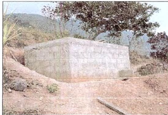
**Figura: 5.97.** Tanque para almacenamiento de agua. (E. Hernández, 2007)
