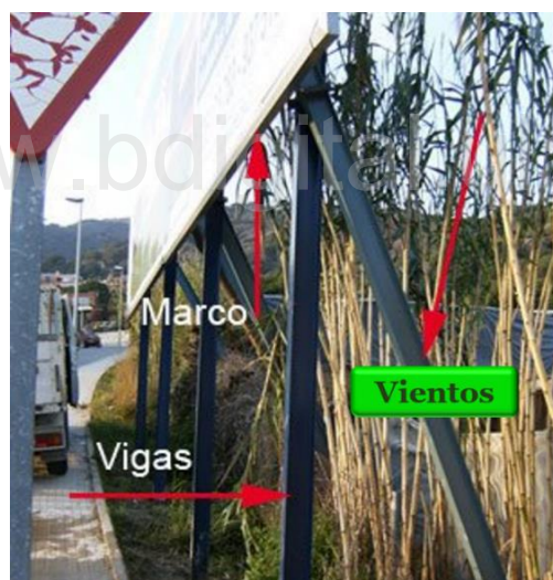
Figura 3.7: Componentes de una valla Vepaco, Parte 3. Fuente: Elaboración Propia.
