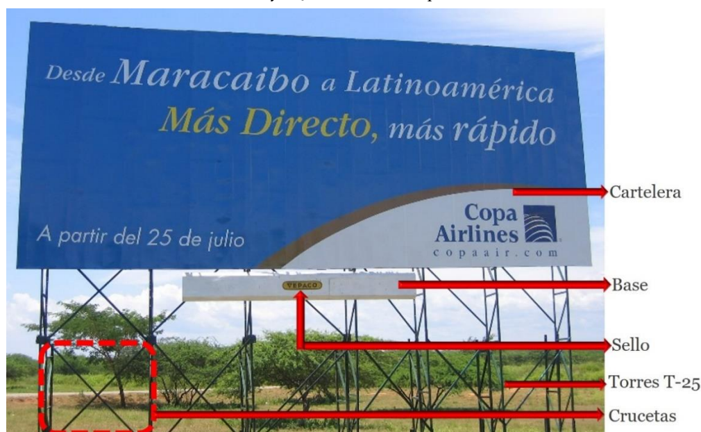
Figura 3.5: Componentes de una valla Vepaco, Parte 1. Fuente: Elaboración Propia.
