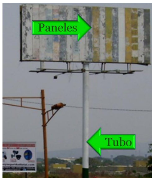
Figura 3.6: Componentes de una valla Vepaco, Parte 2. Fuente: Elaboración Propia.
