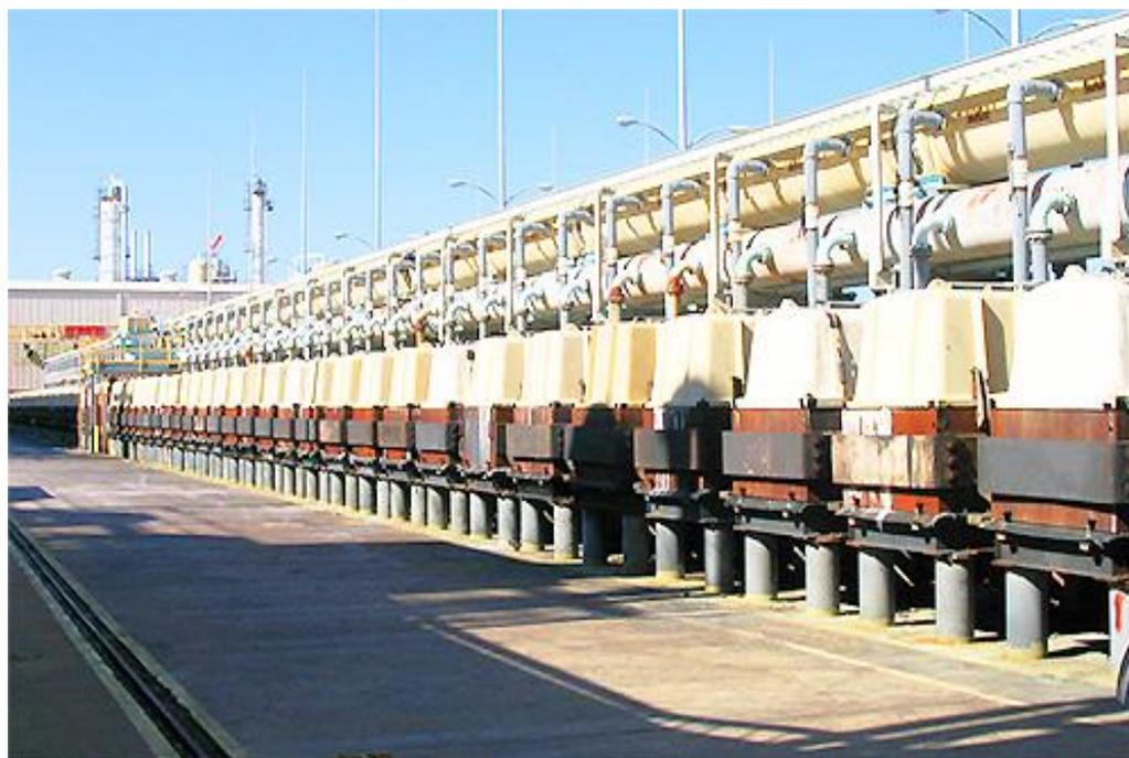
**Figura 4.9. Celdas electrolíticas industriales de cloro-álkali con celdas de diafragma [29a]**
