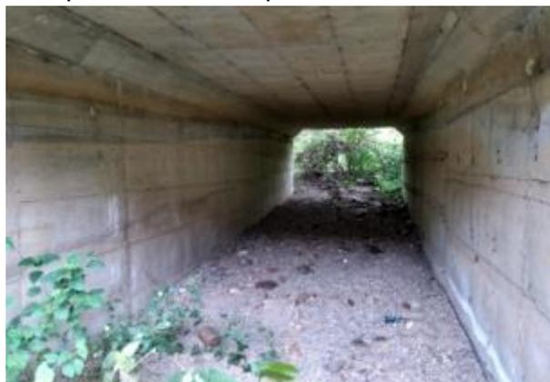
**Figura 5.20.** Dique abierto para el control de torrentes colmatado de sedimentos, ubicado en la quebrada El Barro
