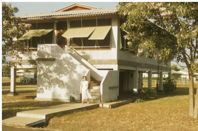
Lagunillas. Campos petroleros. Uso de bases elevadas, techo inclinado y elementos de luz ventilación
