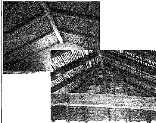
Conformación de los techos
