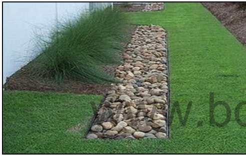
Imagen 5 Zanjas de infiltración
