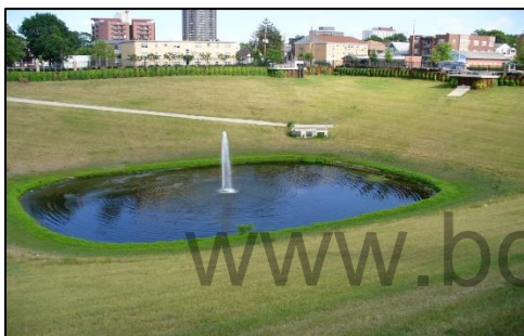
Imagen 11 Estanque de retención
