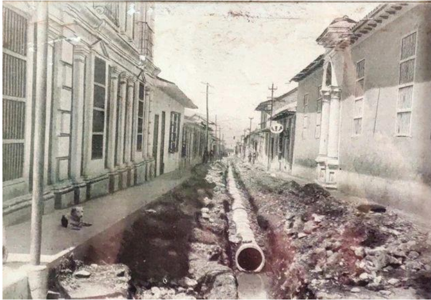
Imagen 26 Empotramiento de cloacas en Mérida 1929.
