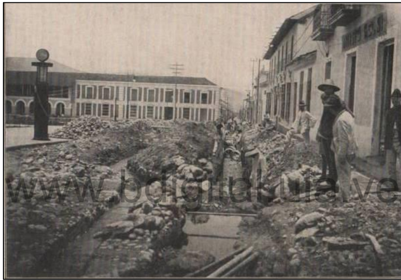
Imagen 25 Instalación de cloacas en la Calle Independencia y Plaza Bolívar. Mérida. Año 1926 Fuente: https://pbs.twimg.com/media/C3nyhUnWEAEWJpl.jpg
