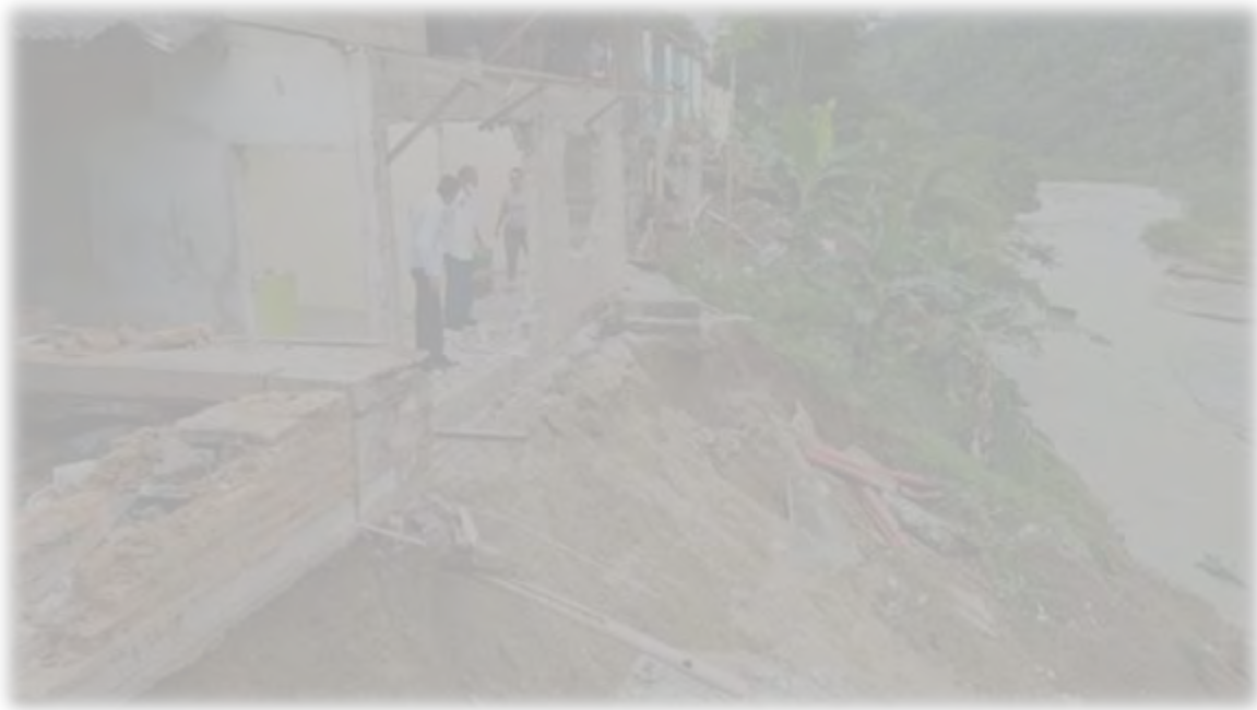
Diario de Los Andes. Lluvias causan estragos en Santa Cruz de Mora. 20/08/2021. Alcaldía Pinto Salinas. https://diariodelosandes.com/lluvias-causan-estragos-en-santa-cruz-de-mora/
