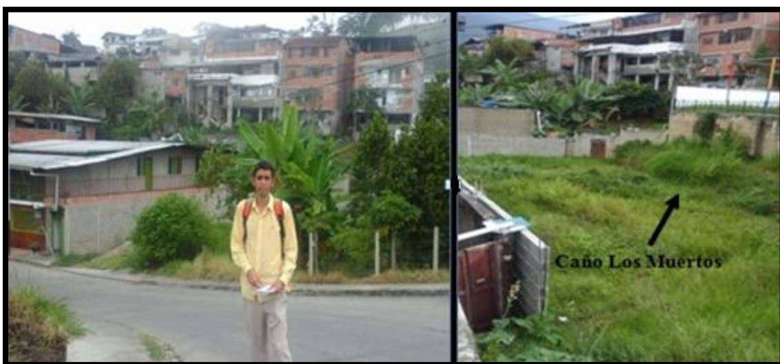
Figura 11. Fotografías zona propensa a deslizamientos, tramo comprendido entre la calle 6 intercepción con la Avenida Zerpa (cercanías de la Plaza Andrés Bello) y la calle 7 en las cercanías del hospital.
