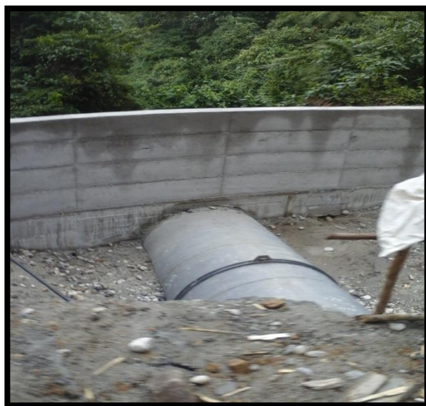
Figura 7. Obras de contención y canalización vía que comunica La Azulita con la ciudad de Mérida.
