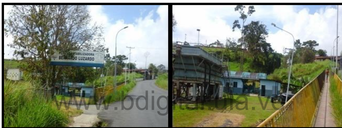
Figura 27. Fotografías instalaciones Planta Potabilizadora Bernardo Luzardo.
