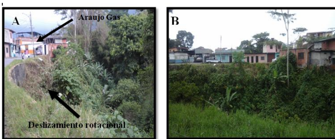
Figura 9. Fotografías Sector Centenario. A. Deslizamiento activo de tipo rotacional que afecta la vía principal de acceso a la Azulita B. Vista posterior deslizamiento activo de tipo rotacional enmascarado por la vegetación y que afecta la vía principal de acceso a la Azulita.
