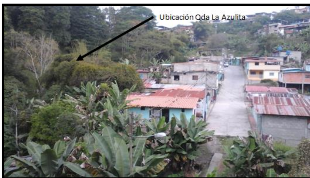
Figura 10. Fotografía Sector Barrio Escondido. Ubicación y cercanía de las viviendas con relación al cauce de la Quebrada. La Azulita 30 metros.
