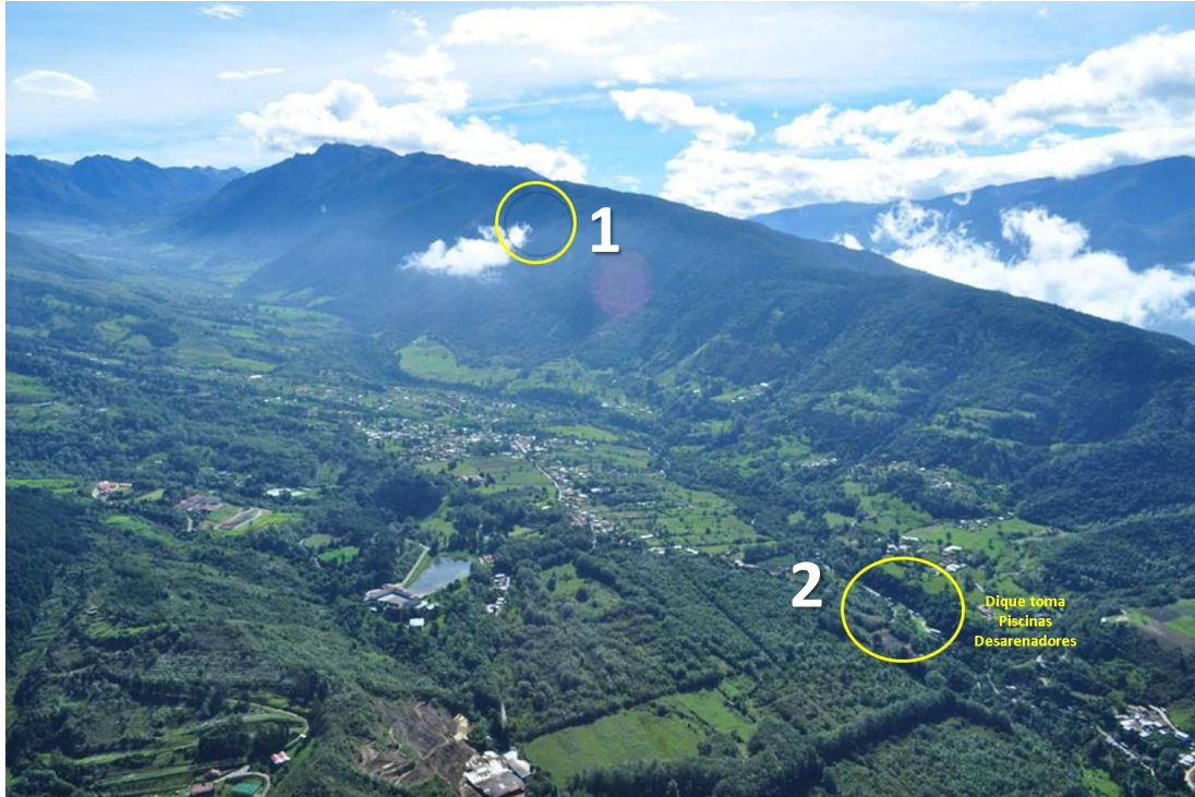
Figura 25. Ubicación del movimiento de masa en la microcuenca El Escorial (1) con respecto a las instalaciones del dique toma y desarenadores de Aguas de Mérida (2).
