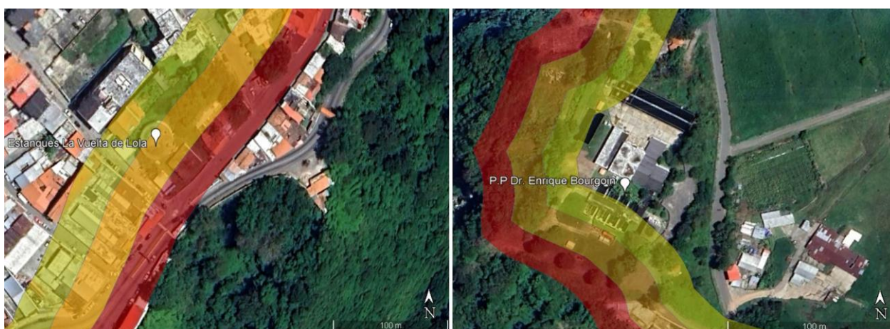
Figura 29 Cercanía al talud de las estructuras que forman parte del subsistema Mucujún izquierda, estanques de almacenamiento La Vuelta de Lola, derecha planta de potabilización Dr. Enrique Bourgoín. Fuente: elaboración propia (2023). Imagen extraída de google earth 2023.
