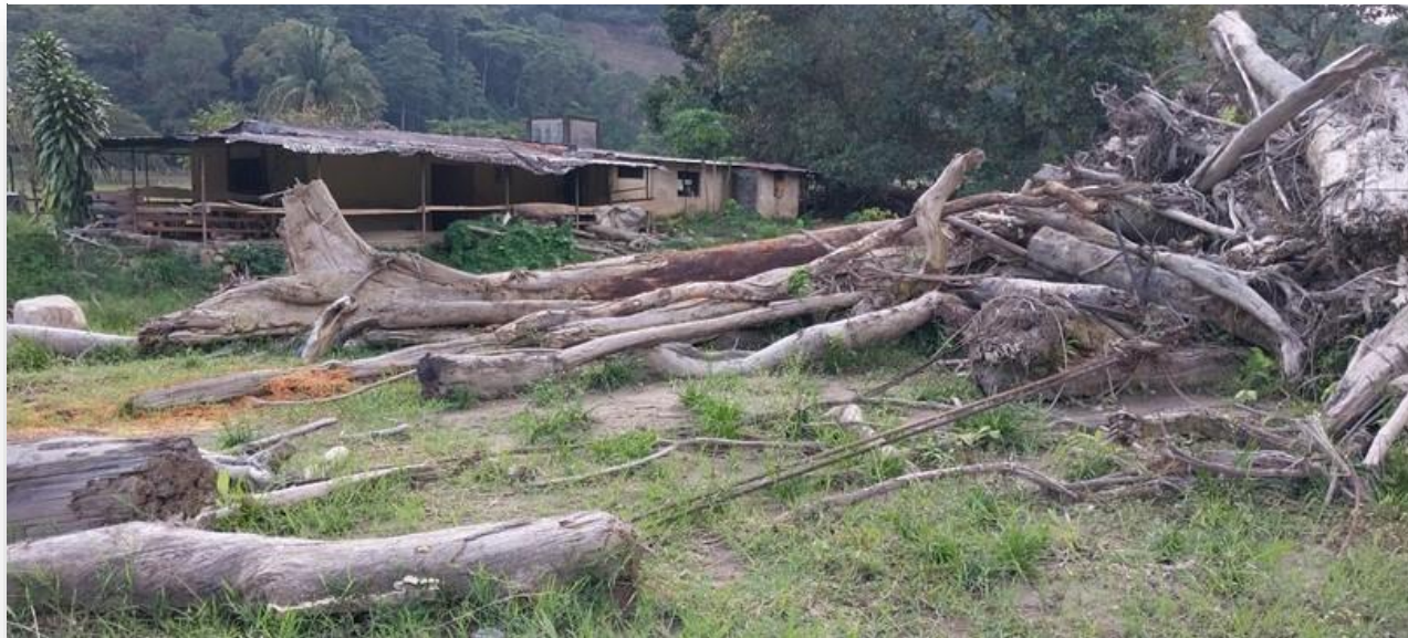
Fotografía 7. Vivienda afectada por la crecida, ubicada en el lecho del río sector La Chiguira
