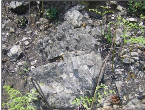
Fotografía 15. Trabajo de campo, área de estudio borde o berma (estimación del espaciamiento entre las discontinuidades)
