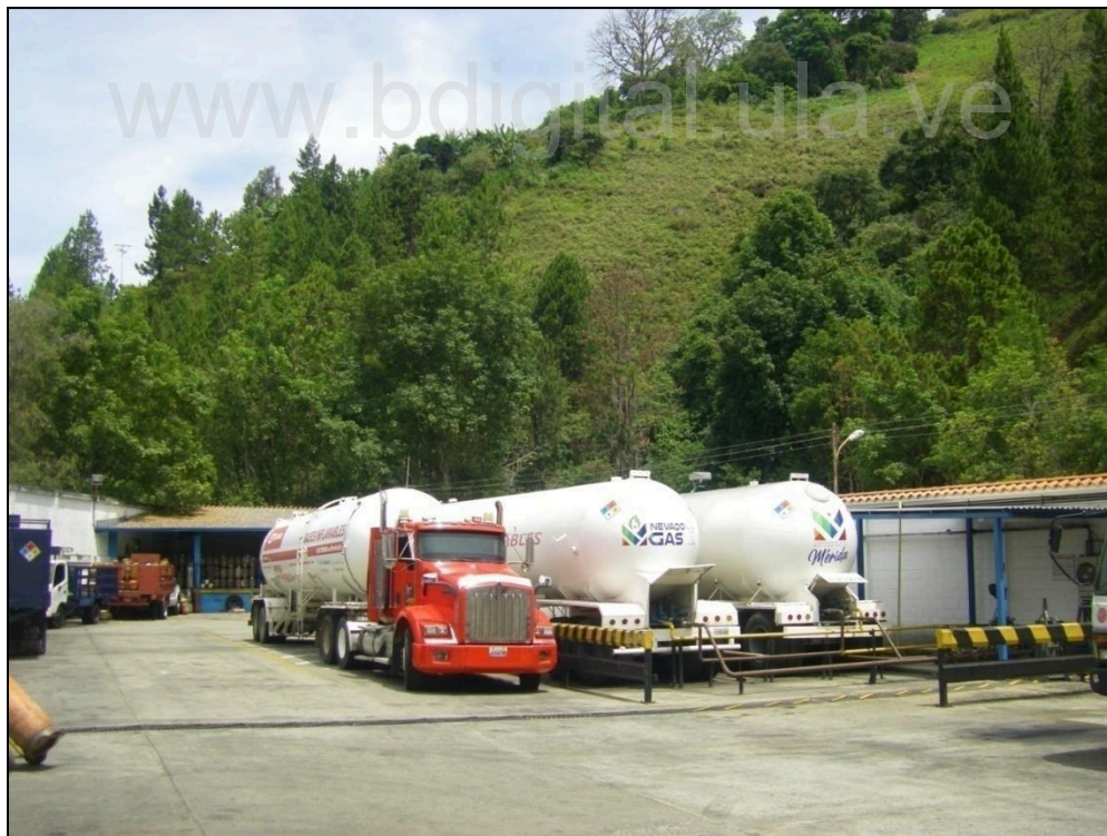
Fotografía 24. Áreas internas de la planta "Gral Jose Justo Briceño Ojalora": áreas de tanques N° 1 y N° 2, (margen derecho), unidad semi-remolque de flota primaria (camión de color rojo), área de patio y área de reparaciones menores y pintura (al fondo), área de bombas y compresores (margen derecha).
