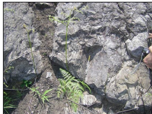
Fotografía 14. Trabajo de campo, área de estudio parte intermedia e inferior (estimación del espaciamiento entre las discontinuidades)
