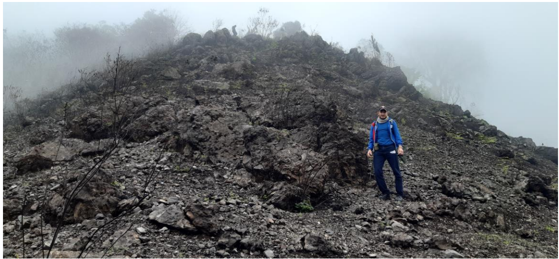
Fig. 6. Fotografía de la ladera frontal a la instalación industrial, macizo rocoso principal (fotografía tomada en diciembre de 2021).
