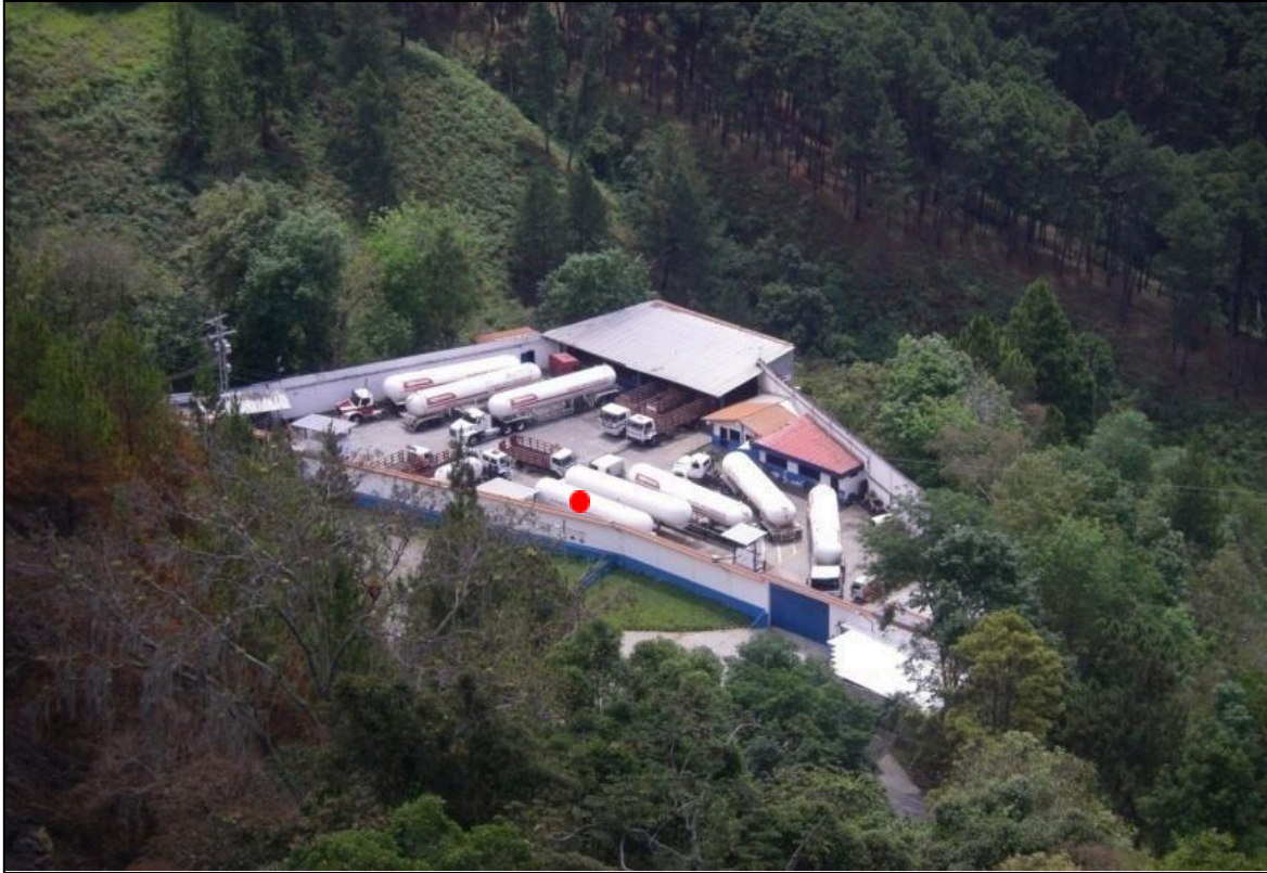
Fotografía 26a. Espacios internos de la instalación de servicios industriales planta "Gral. Justo Briceño Ojalora". (El punto rojo en la parte lateral del tanque (N°1) de almacenamiento de GLP, representa el área de impacto del material desprendido).
