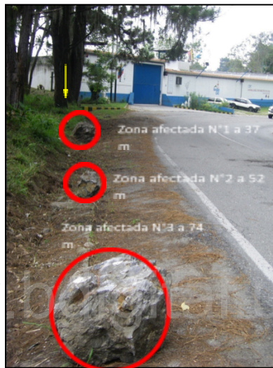
Fotografía 3. Caidos (identificados en círculo rojo) en las inmediaciones de la Instalación de servicios industriales Planta "Gral. Jose Justo Briceño Otalora". Distancias parciales tomadas a partir de un punto fijo de referencia, en la esquina izquierda de la Planta, identificado con la flecha de color amarillo.
