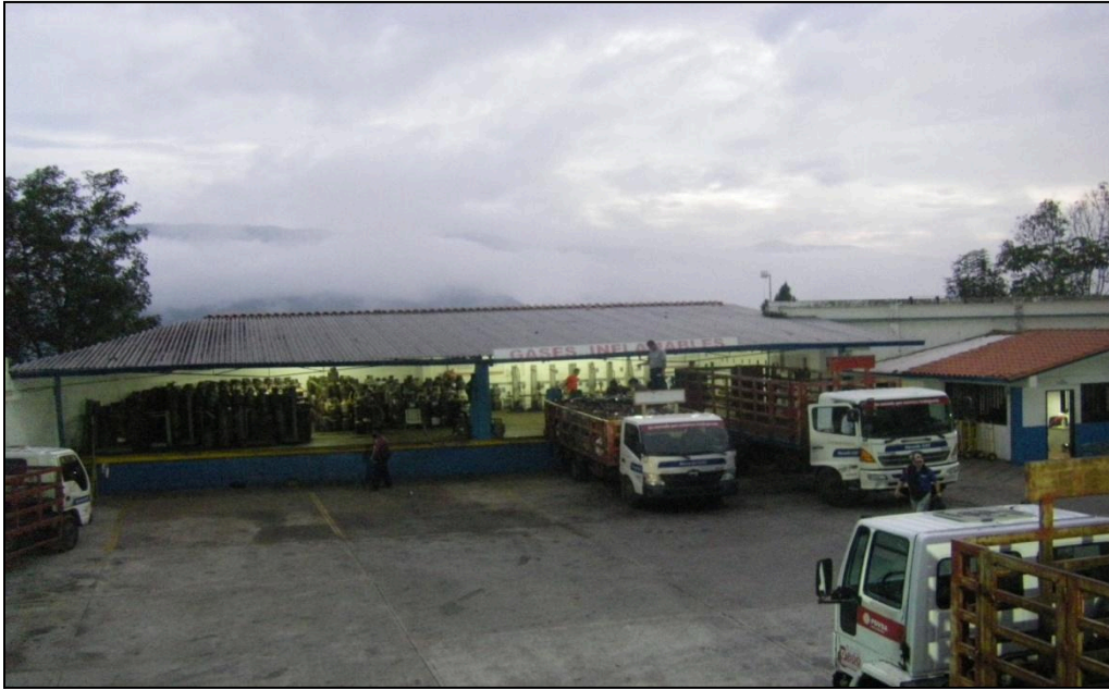
Fotografía 23. Áreas internas de la planta "Gral Jose Justo Briceño Ojalora". (De izq. a der.): área de plataforma de alivio, plataforma de llenado con los picos de llenados (al fondo) y áreas administrativas.
