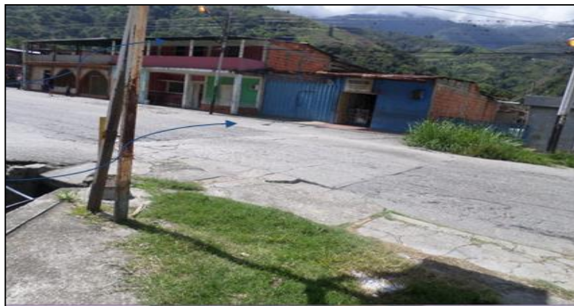
Figura 103. Se aprecian las edificaciones construidas en la misma dirección de flujo hídrico subcuenca Las Calaveras (C-05). Fuente: Vera, M. (2023).
