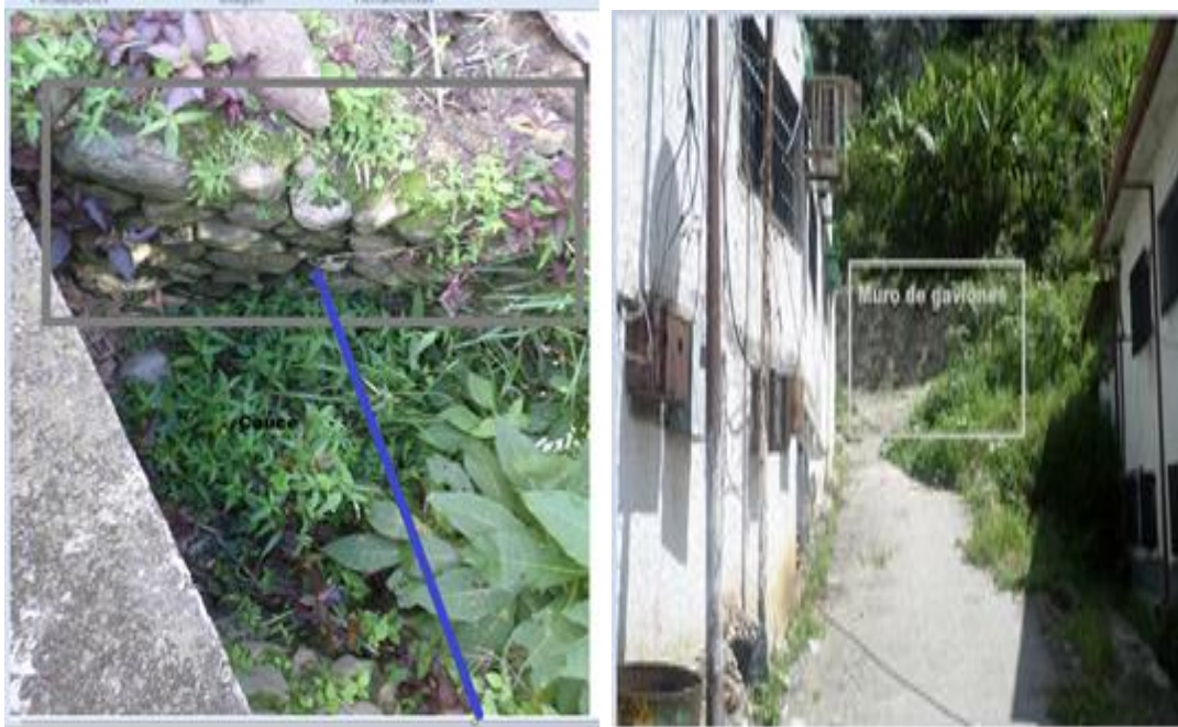
Figuras 65 y 66. (a) Se muestran medidas correctivas: la obra de control de escorrentía (izq.). (b) Muro de gaviones. (Dar). Fuente: Vera, M. (2023).
