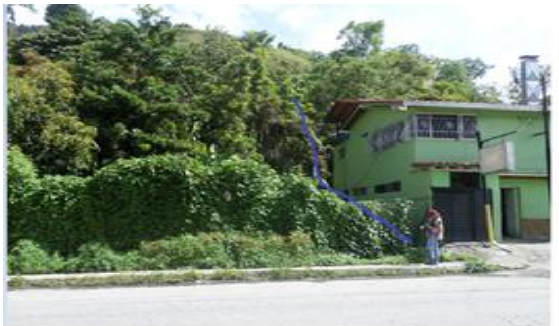
Figura 59. Punto crítico 2. Edificación bifamiliar dentro del cauce fluvial. Coordenadas: Este: 268174 m; Norte: 953543m; Altitud: 1561m. Fuente: Vera, M. (2023).
