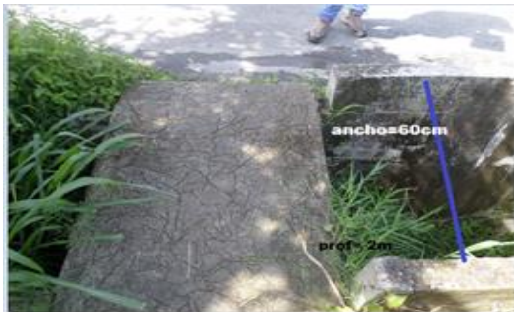
Figura 61. Se muestran las dimensiones de la obra correctiva. Fuente: Vera, M. (2023).
