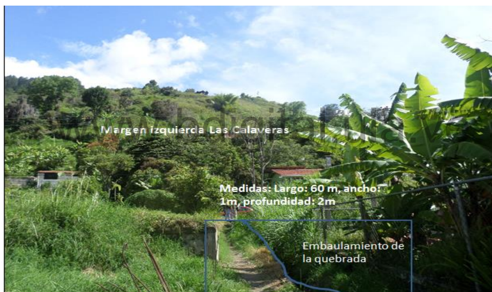
Figura 60. Punto crítico 3. Se observa el embaulamiento del canal activo. Coordenadas: Este: 2688004 m; Norte: 953462m; Altitud: 1558m. Las Calaveras 04. Fuente: Vera, M. (2023).
