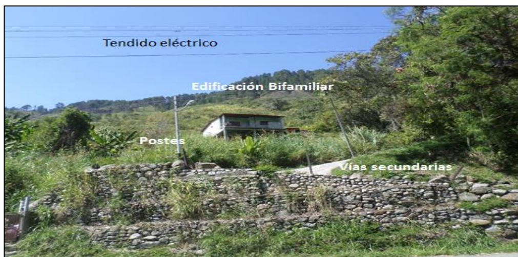
Figura 46. Se destaca la fragilidad de las viviendas, tendido eléctricos y postes en la subcuenca Calaveras (C-03). Fuente: Vera, M. (2023).
