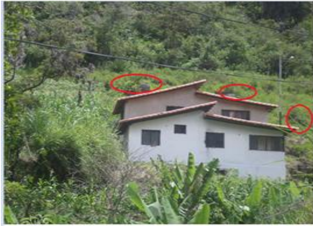
Figura 72. Se muestra construcción en terrenos que manifiestan movimientos de masa tipo caídas de rocas. Fuente: Vera, M. (2023).
