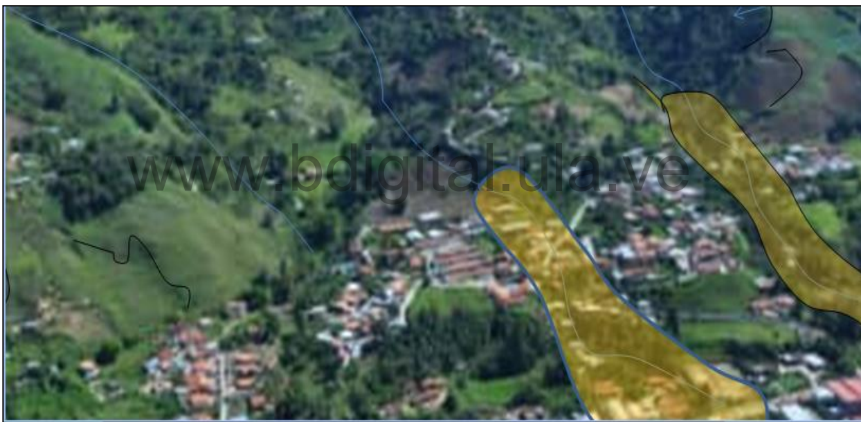
Figura 102. De acuerdo a las fotografías otorgadas por INPRADEM, se analizan edificaciones construidas en la misma dirección de flujo hídrico. Fuente: Vera, M. (2023).
