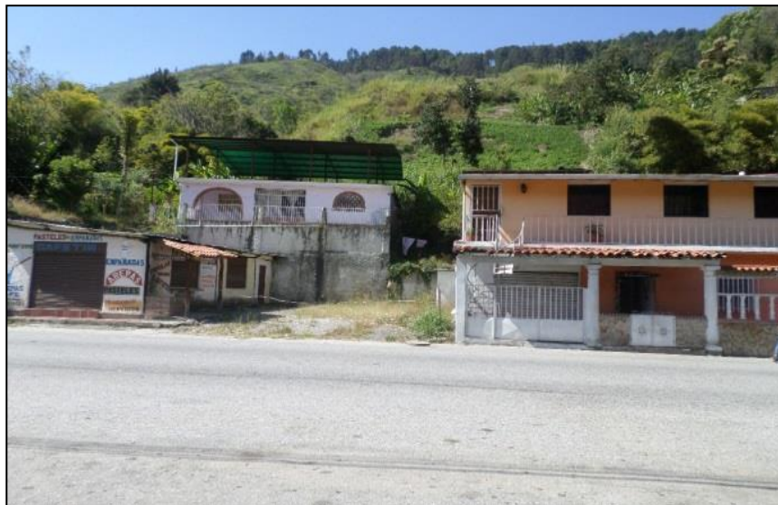
Figura 97. Edificaciones asentadas en la actualidad en el sector Las Calaveras (C-02) que pueden ser afectadas por futuros procesos hidrometeorológicos. Fuente: Vera, M. (2023).
