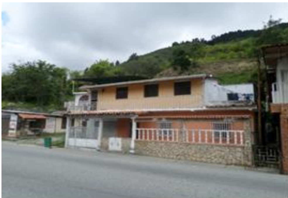
Figura 77. Se muestra la zona donde existió afectación a la vialidad y daños a las edificaciones bifamiliares en eventos torrenciales. Actualmente reconstruida. Fuente: Vera, M. (2023).
