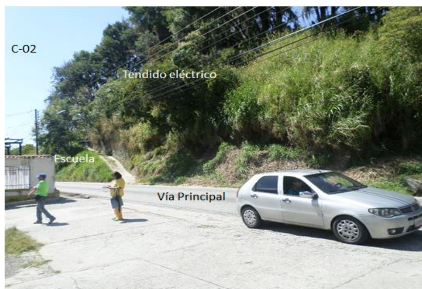
Figura 42. Se muestran los elementos a sufrir daños (vías principales, escuelas, tendido eléctrico y edificaciones) en el sector Las Calaveras 02. (C-02). Fuente: Vera, M. (2023).
