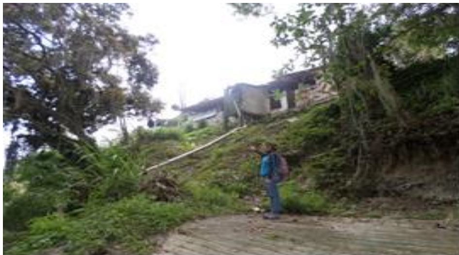
Figura 75. Viviendas construidas sobre un material disgregado de poca compactación, y de fácil meteorización. Fuente: Vera, M. (2023).
