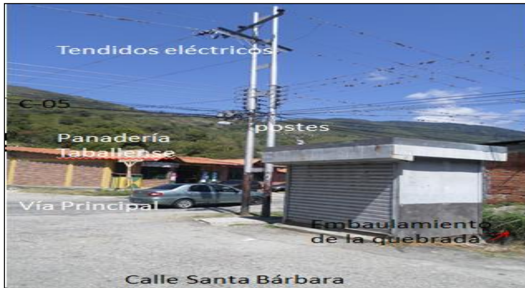
Figura 54. Se nombran los elementos expuestos que pueden sufrir daños por crecida de la subcuenca Las Calaveras (C-05). Fuente: Vera, M. (2023).
