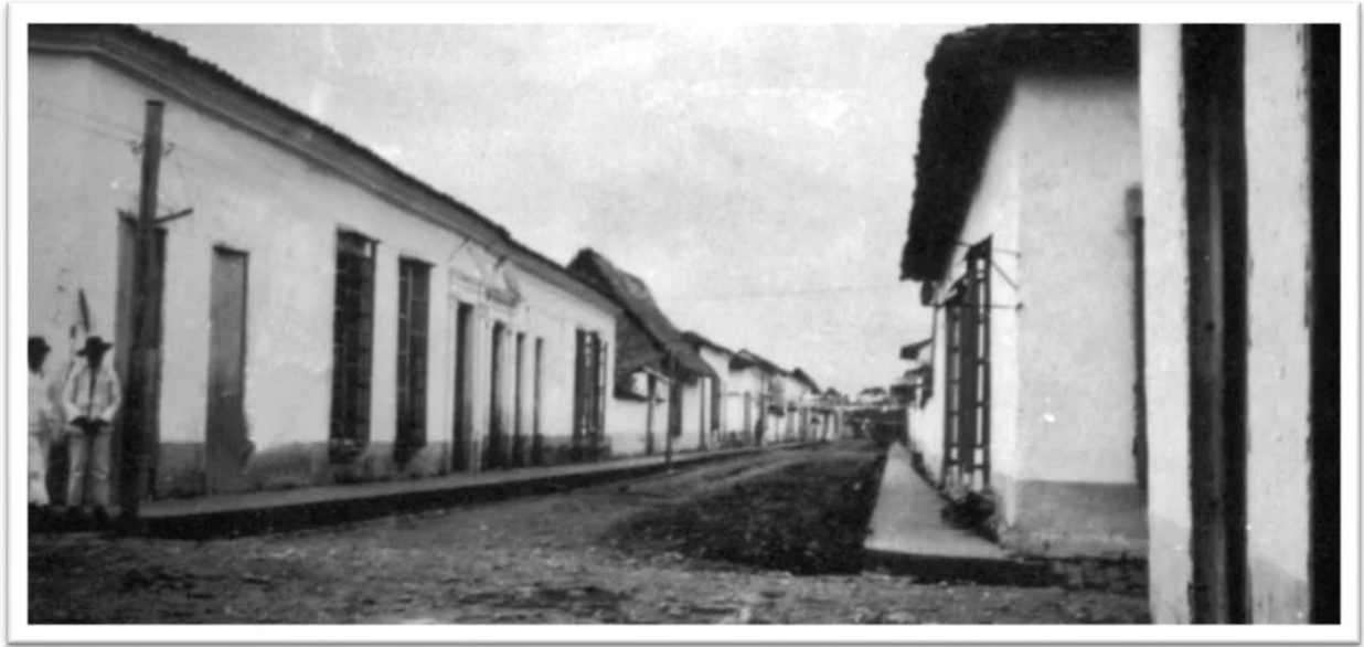
Figura N° 22. Calle Real de la ciudad de Barinas. 1926 Fuente: Archivo-Cronista-de-Barinas-don-Cesar-Acosta
