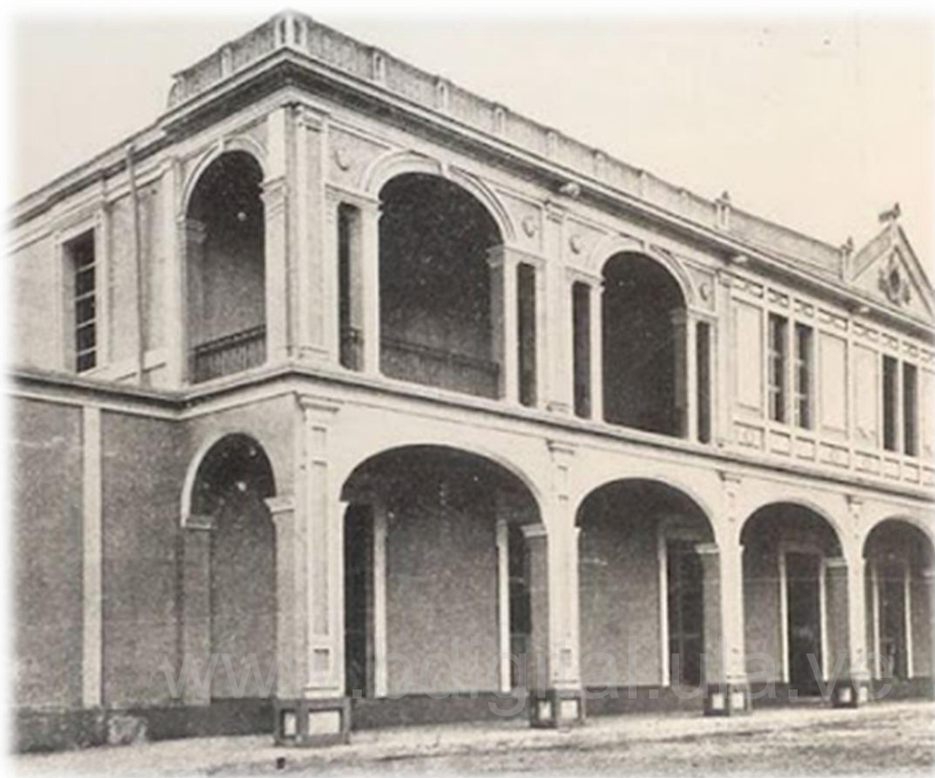
Figura N° 40: Casa comercial alemana de Maracaibo. Breuer Moller Co Fuente: saldiviadevenezuela.blogspot/2018/10/la-economia-cafetalera-y-las-casas.html
