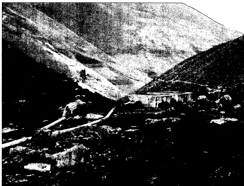
Figura 11. Toma de agua de los cauces de las cuencas.
