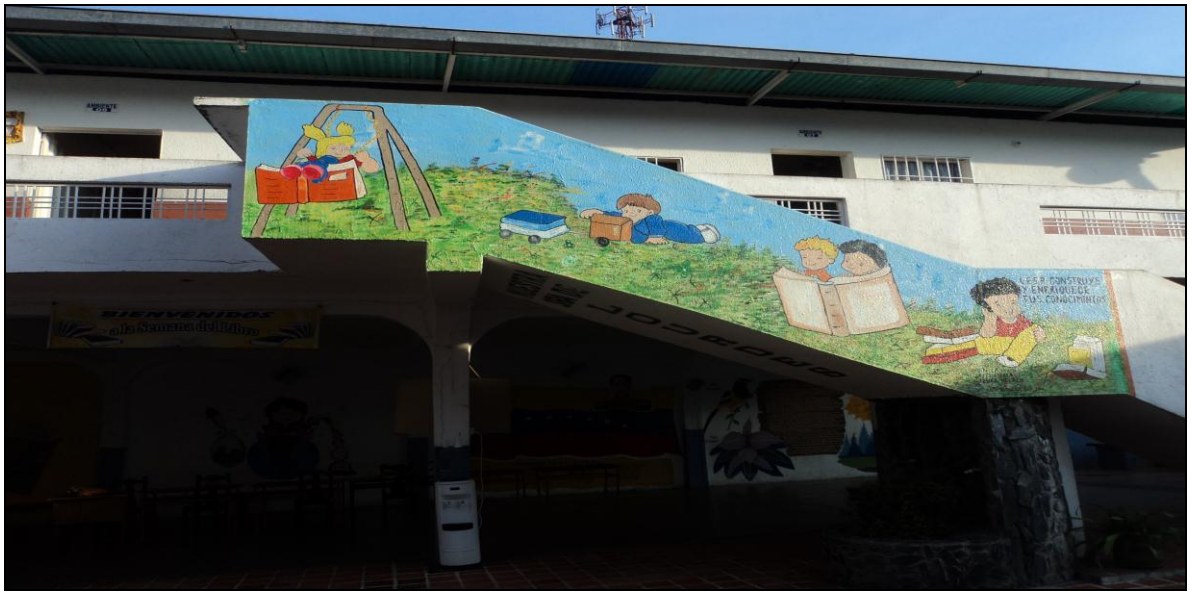
Foto N° 3. Infraestructura de la Institución
